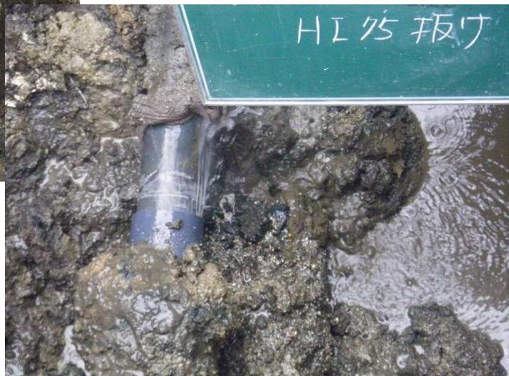
写真 5.3.11 φ75 塩化ビニル管 抜け (東区秋津2丁目, 配水 No. 214)
