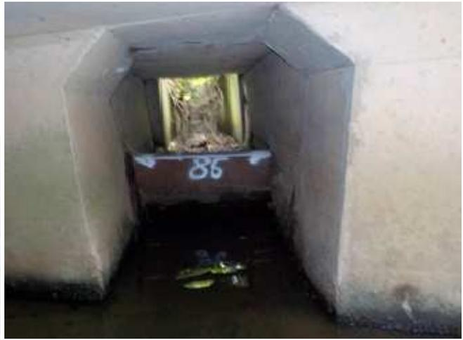
写真 5.3.8  $\phi 350$  鑄鉄管 管体被害 (西区上熊本 3 丁目, No. 33)
