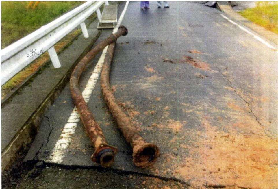
写真 5.4.2 断層横断部の DIP K 形 φ 100 抜け
