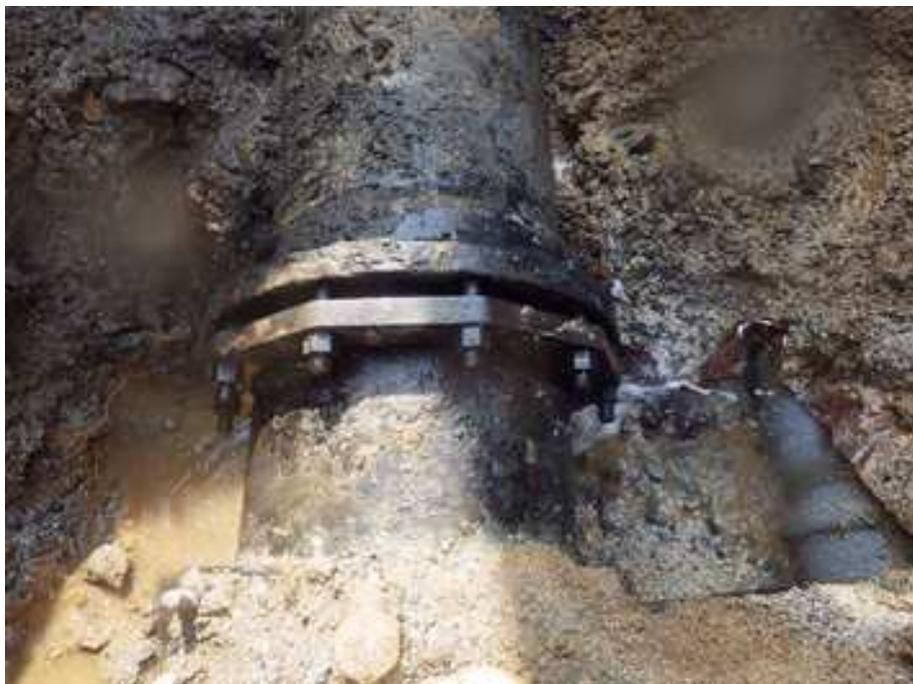
写真 5.3.9  $\phi 350$  鑄鉄管 (A 形) 抜け出し (東区沼山津 3, 配水 No. 34)
