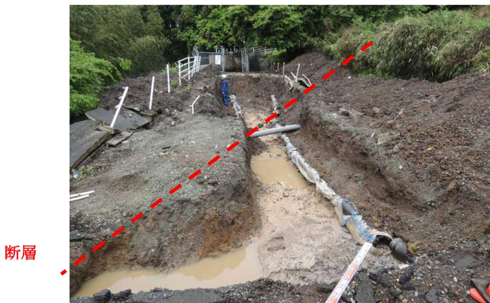
写真 5.7.1 断層部における DIP A 形  $\phi 200$ ,  $\phi 250$  2 条配管抜け被害
