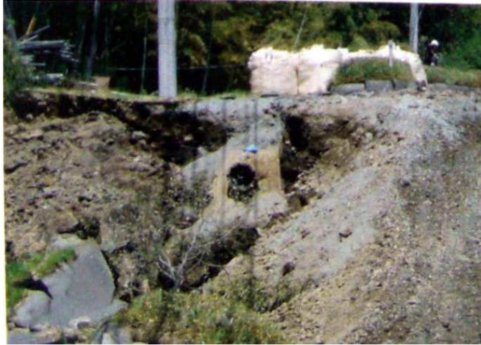
写真 5.4.3 DIP K形  $\phi$  350 継手抜け (益城町寺迫)
