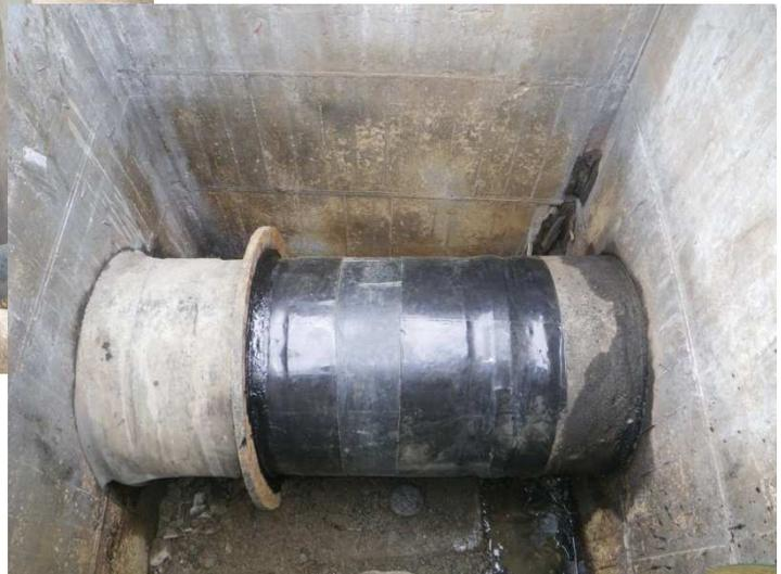
写真 5.3.15  $\phi$  700 仕切弁破損部の補修状況（東区秋津町沼山津, 同上）
