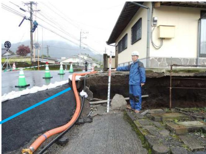
写真 5.5.1 断層横断部での HIVP  $\phi$  100 被害
