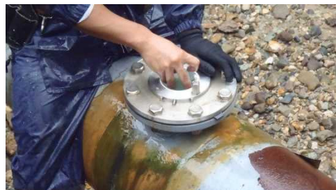
空気弁分解点検
