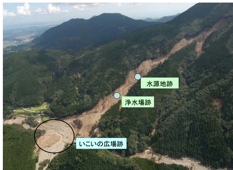
土砂崩壊状況(宮崎県県土整備部提供) 11
