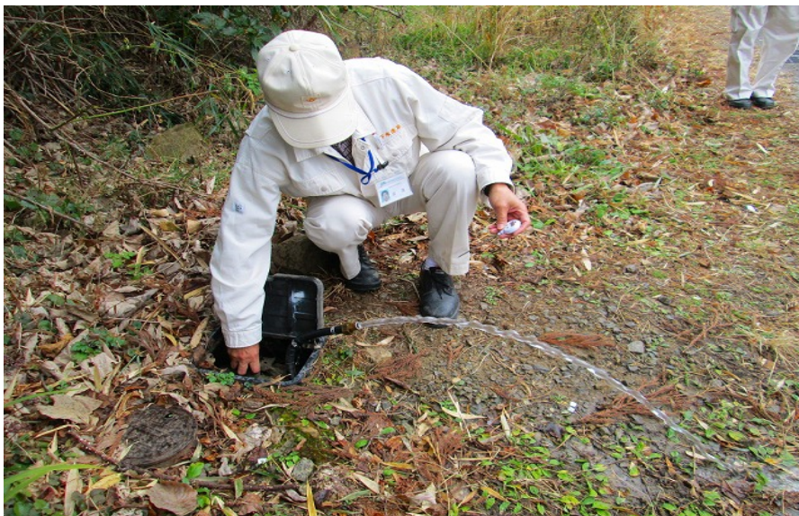
配水管末端部ドレンでの排水状況
