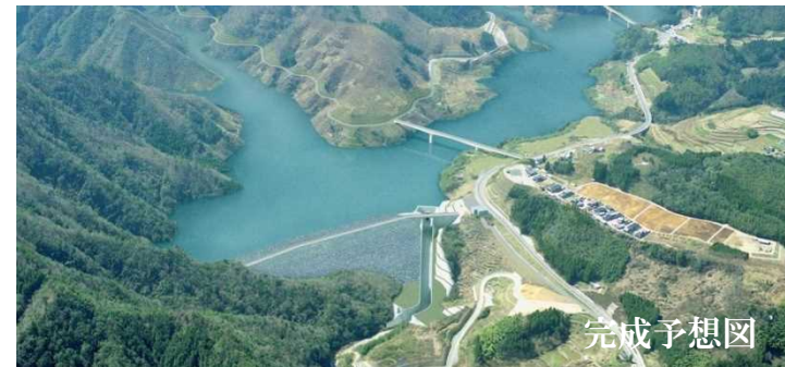
「大分川ダム(ななせダム)」 総事業費 約995億円/ロックフィルダム 総貯水容量 約24,000千 \text{m}^3
