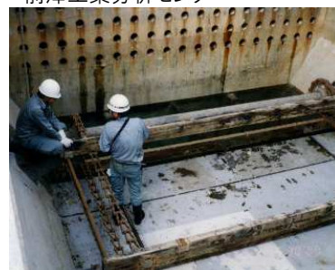
沈澱池機械の点検調査
