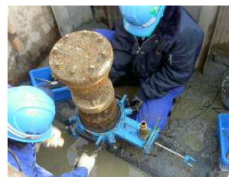
補修弁取替工法
