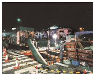
管更生工事（パルテム HL 工法）
