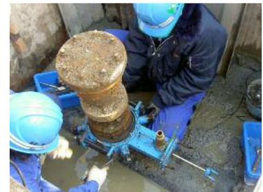
補修弁取替工法
