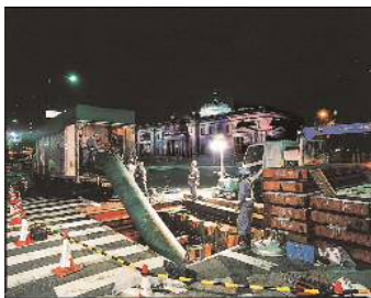
管更生工事（パルテムHL工法）
