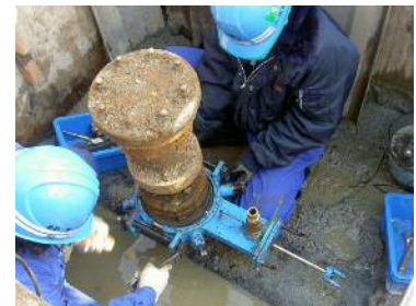
補修弁取替工法
