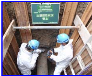
埋設環境調査
