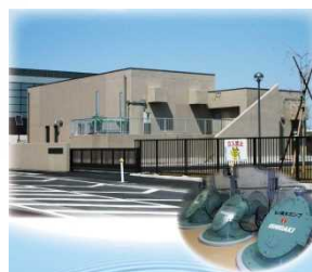
内日角雨水ポンプ場
