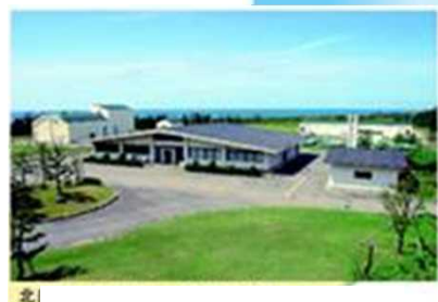
北部浄化センター
