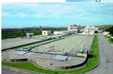
南部浄化センター
