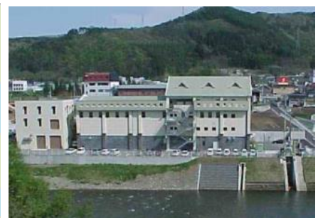
二戸市浄水場
