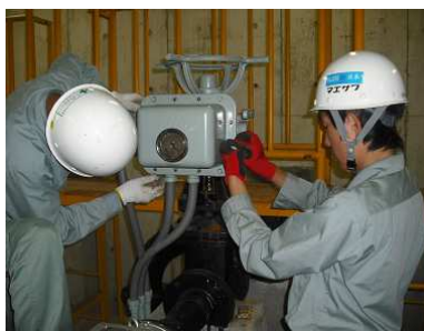
バルブの点検調査
