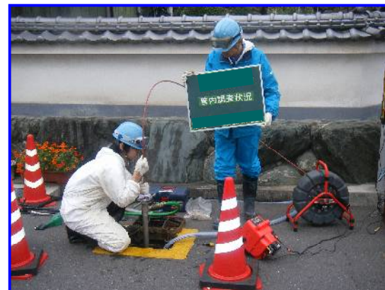
管内調査(不断水管内カメラ調査)
