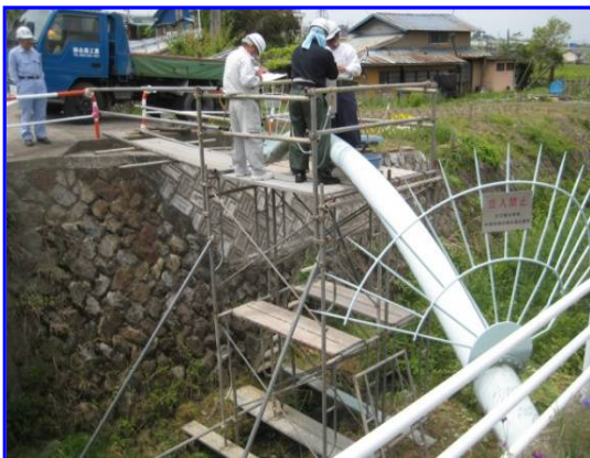
水管橋点検(弁柱類点検)
