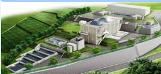
基山浄水場浄水施設更新事業 (佐賀東部水道企業団様)
