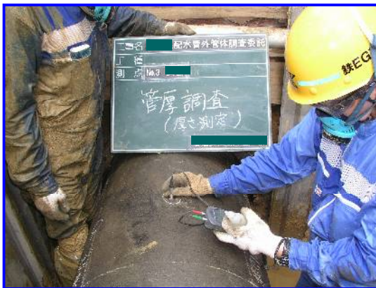
管体調査(超音波管厚測定)
