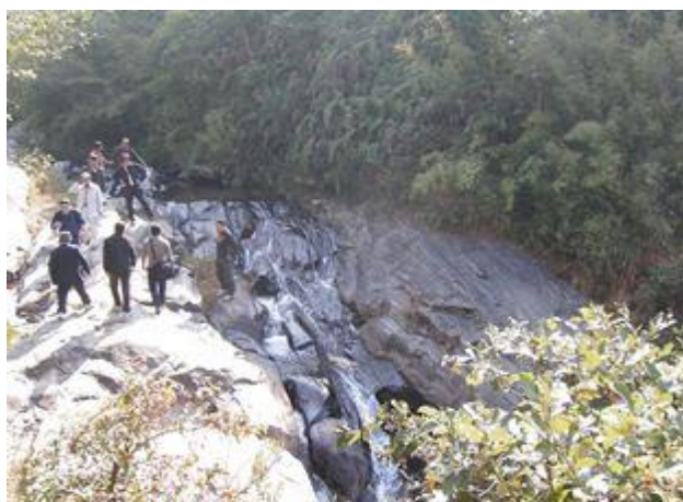
ダム予定地 堤体部
