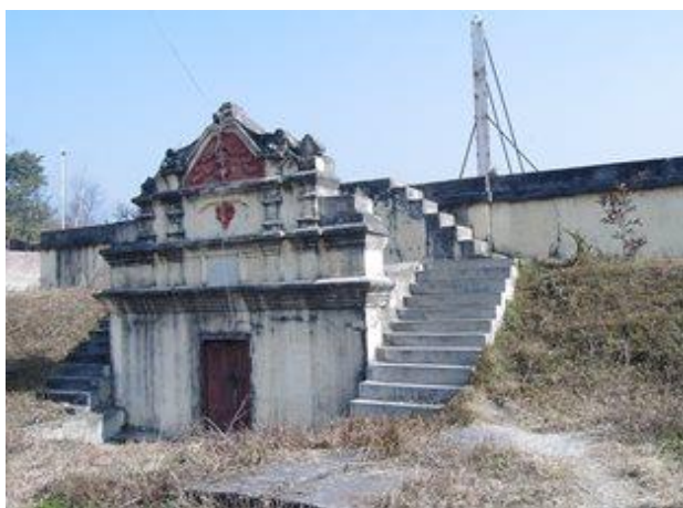
バンスバリ浄水場 浄水池兼配水池
