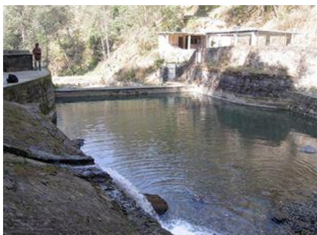
マハデブ川 取水堰 上流から見る
