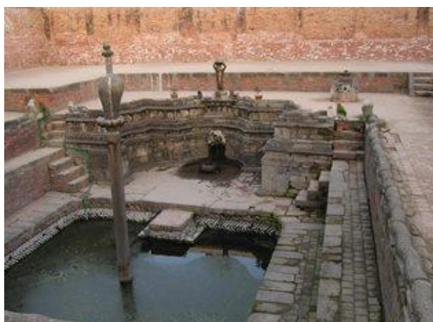
旧宮殿内の石造りの水栓 かつては共同の水汲み場として利用されていた。
