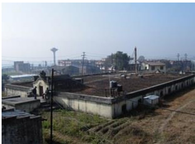
バンスバリ浄水場 浄水池兼配水池
