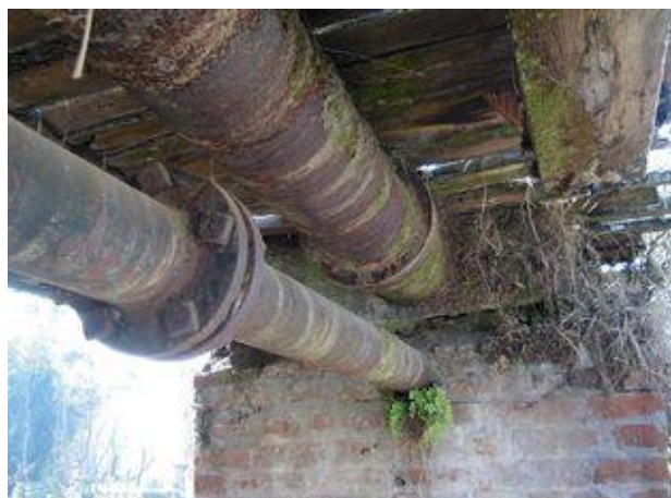
既設配管の小河川横断地点
