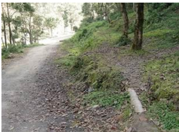
取水堰～浄水場間の既設配管ルート
