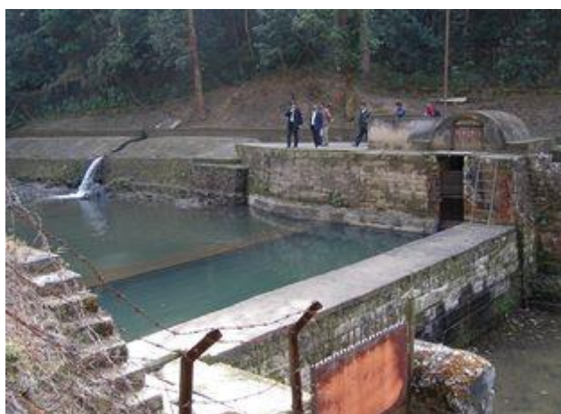
マハデブ川 取水堰 下流から見る
