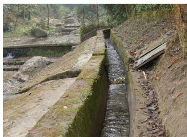
マハデブ川 取水堰横の水路
