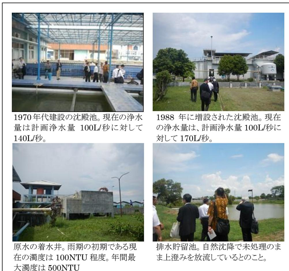
1970 年代建設の沈殿池。現在の浄水量は計画浄水量 100L/秒に対して 140L/秒。
