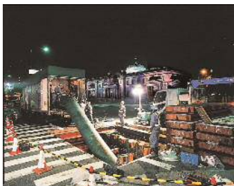
管更生工事（パルテムHL工法）
