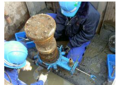
補修弁取替工法
