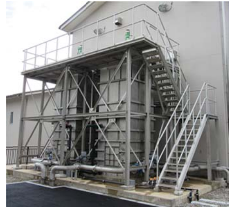
帯磁性イオン交換樹脂 (MIEX ® ) 処理システム
