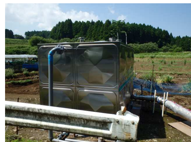
写真 6.6.5 仮設減圧水槽（小森減圧槽）
