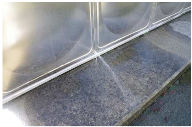
写真 6.7.3 つつじ台配水池の被害（大津菊陽水道企業団）
