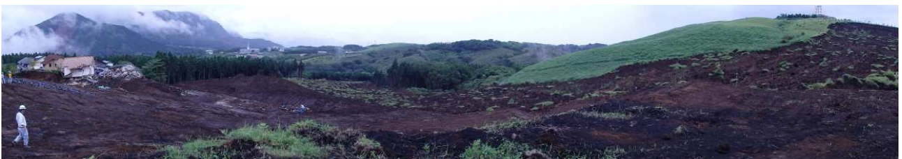
写真 6.5.2 高野台配水池付近の斜面崩壊
