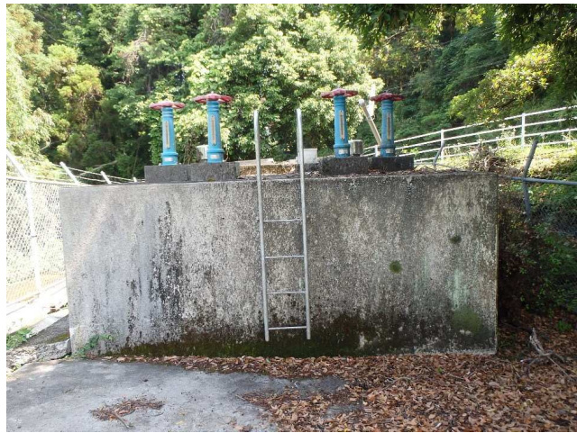
写真 6.6.3 小森減圧槽の傾斜
