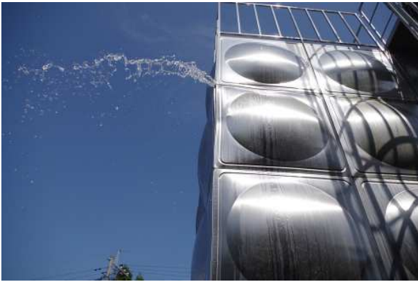
写真 6.7.3 つつじ台配水池の被害（大津菊陽水道企業団）
