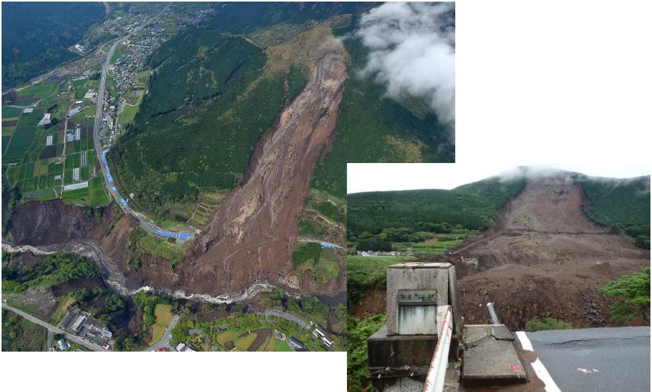
写真 6.5.1 阿蘇大橋崩落現場
