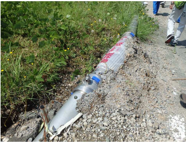
写真 6.6.2 小森減圧槽配水管の 仮設配管（リース）
