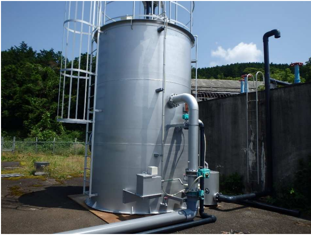
写真 6.6.1 大峯配水場 仮設急速ろ過池（レンタル）
