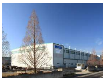
(写真) 鋼管工場
