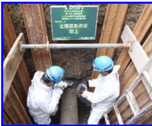
埋設環境調査
