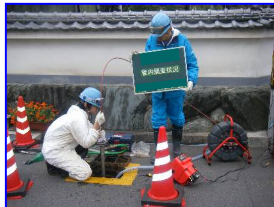
管内調査(不断水管内カメラ調査)
