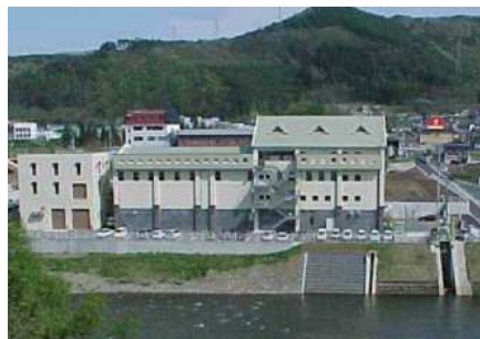
二戸市浄水場
