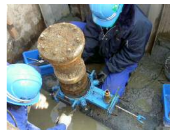
補修弁取替工法
