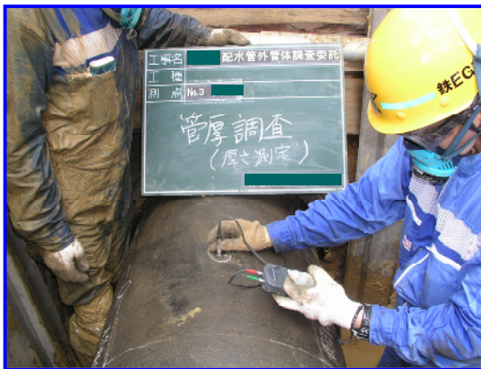
管体調査(超音波管厚測定)
