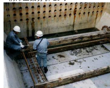
沈澱池機械の点検調査
