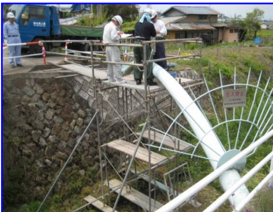
水管橋点検(弁栓類点検)
