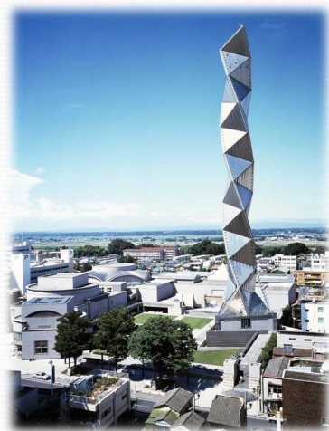
水戸芸術館 (ART TOWER MITO) 写真提供: 水戸芸術館
