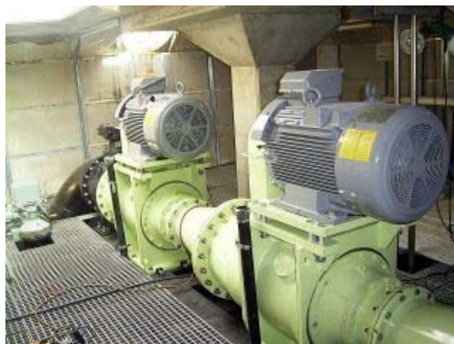
江ヶ崎発電所
