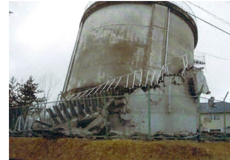
一関市沢配水池
