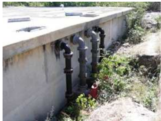
Tanque de distribución existente (capacidad: 1.100 m 3 )
