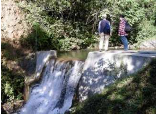
Presa de toma de agua del río Matasano del sistema fluvial de Matasano
