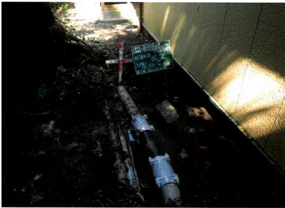
写真 2-4 応急復旧（台風第 15 号；千葉県鴨川市）
