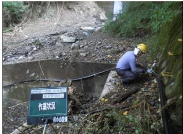
写真 3-43 道路崩落による管体の被害（台風第 19 号；神奈川県相模原市緑区青根）
