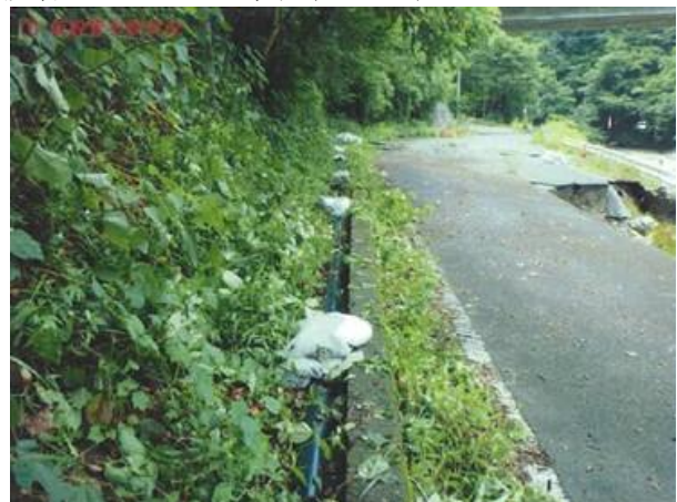
仮設管布設状況②
