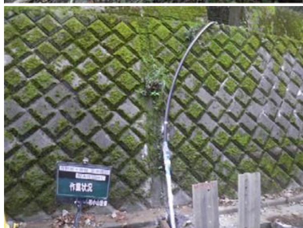
写真 3-44 道路崩落による管体の被害の応急復旧 （台風第 19 号；神奈川県相模原市緑区青根）
