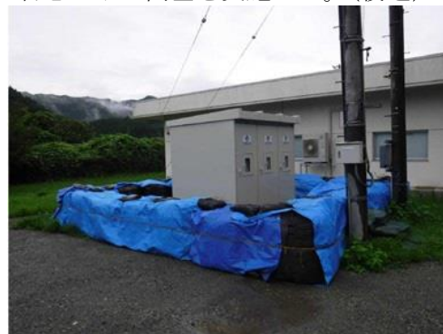
法田ポンプ場
