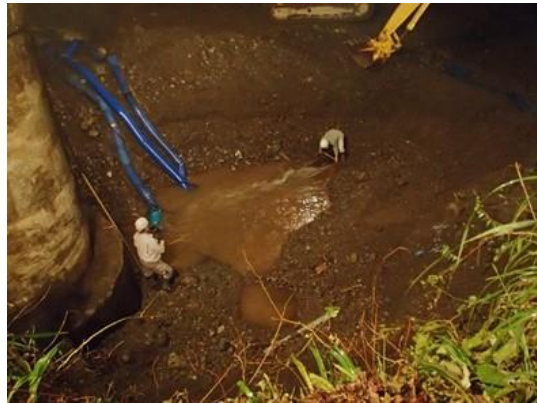
写真 3-26 多孔管（ヒューム管）の破損（台風第19号；神奈川県山北町 皆瀬川浄水場）
