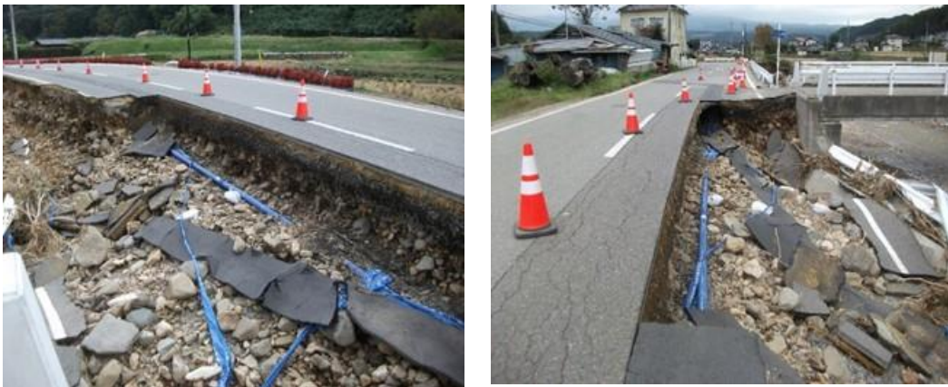
約 12m 露出した現場
