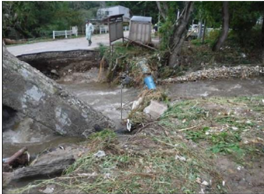
写真 3-54 橋台の洗堀、落橋による添架管の破損（台風第 19 号；宮城県南三陸町坂の貝川水管橋）
