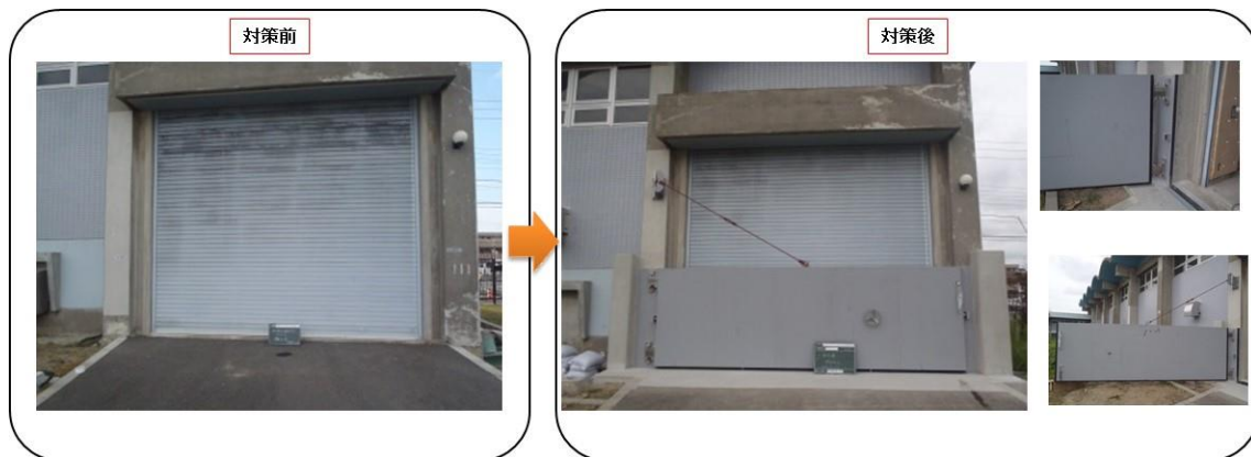
写真 4-8 防水壁の設置（東京都水道局 西瑞江給水所）
