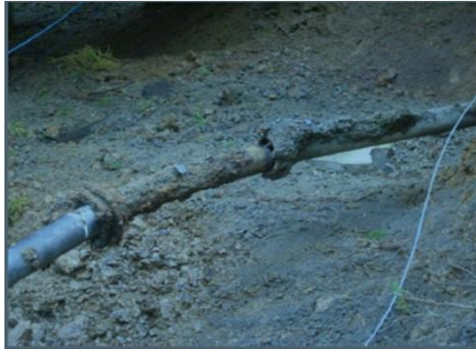
写真 3-45 地盤崩落による継手離脱（台風第 19 号；埼玉県東秩父村大字御堂）
