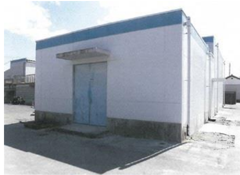
写真 4-3 建物窓、扉の閉塞（福島県いわき市 下平窪取水場）
