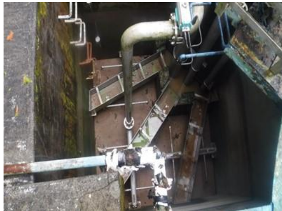
写真 3-27 浄水場への土砂流入（台風第19号；神奈川県山北町 皆瀬川浄水場）
