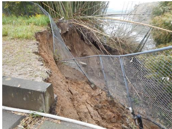
写真 3-16 河川増水による護岸崩落（台風第 19 号；茨城県水戸市 枝内取水場）
