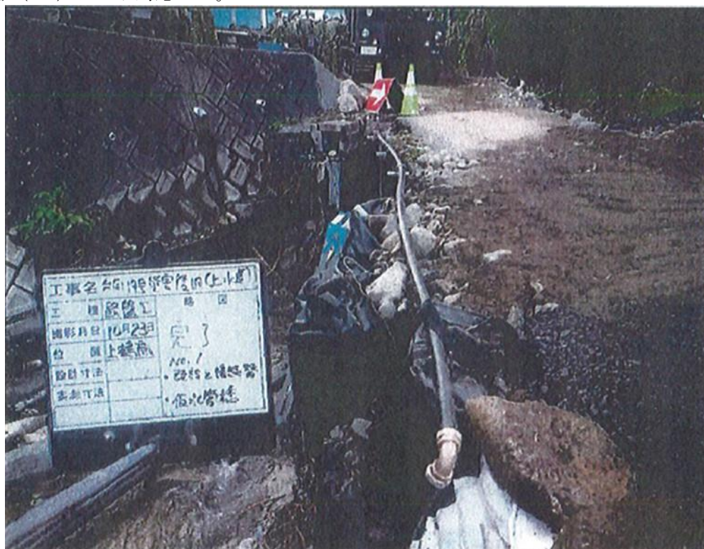
写真 3-61 河川増水による橋梁の流失の応急復旧 (台風第 19 号；岩手県宮古市 上野一の橋添架管)
