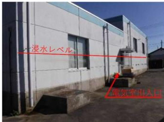
写真 3-5 電気室出入口付近浸水レベル（台風第 19 号；福島県いわき市 下平窪取水場）
