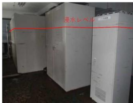
写真 3-6 電気室内浸水レベル（台風第 19 号；福島県いわき市 下平窪取水場）
