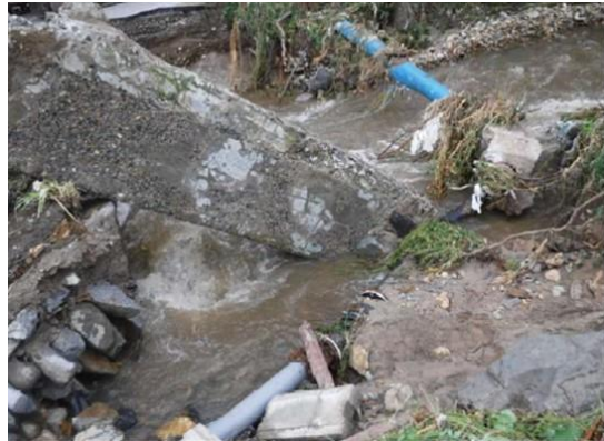
写真 3-54 橋台の洗堀、落橋による添架管の破損（台風第 19 号；宮城県南三陸町坂の貝川水管橋）
