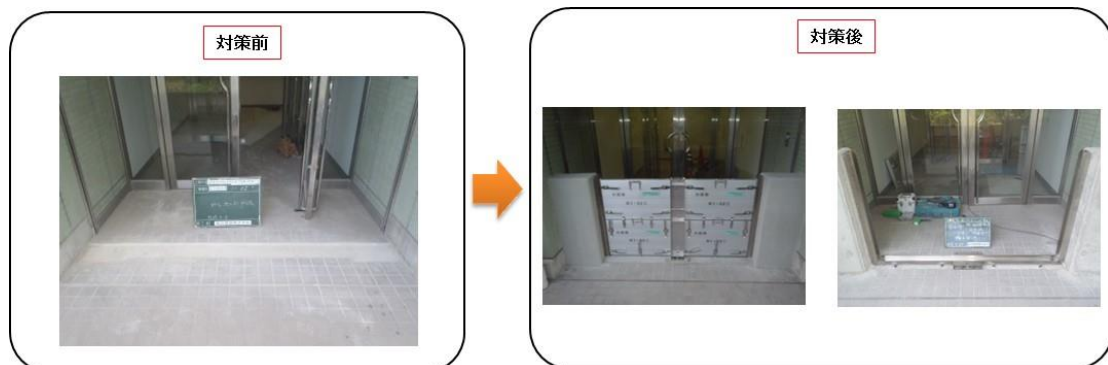
写真 4-10 止水板の設置（東京都水道局 南千住給水所）
