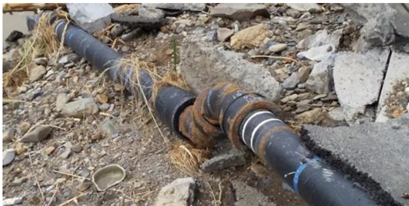
管路状況（大きな傷や継手の抜出しなし）
