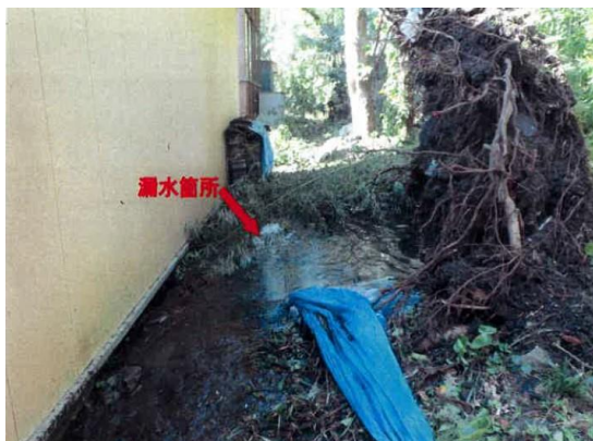
写真 2-3 倒木の根による埋設管の破損（台風第 15 号；千葉県鴨川市）
