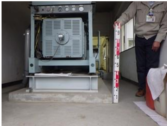
自家発電設備チャンネルベース嵩上げ
