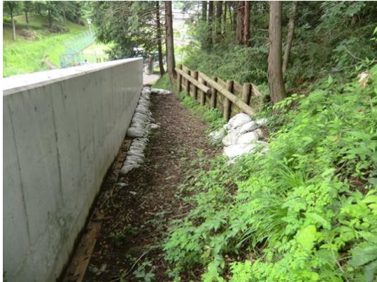
写真 4-23 接合井防護施設（栃木県宇都宮市 高間木取水場）
