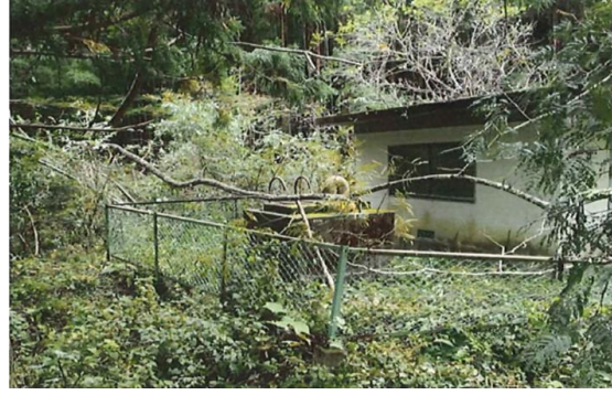
写真 3-31 風倒木によるポンプ井受水槽の蓋の開閉不能 (台風第 19 号；茨城県大子町 西金第 5 加圧機場)
