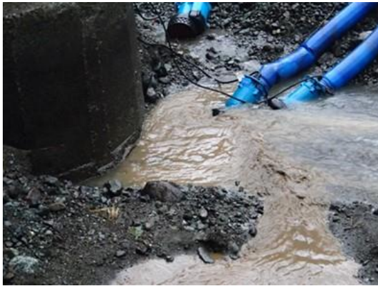
写真 3-26 多孔管（ヒューム管）の破損（台風第19号；神奈川県山北町 皆瀬川浄水場）
