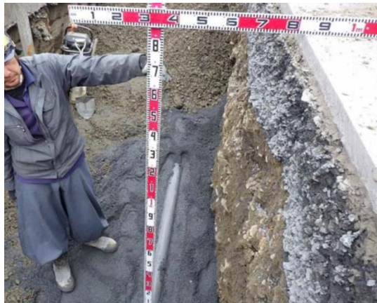
写真 3-34 道路崩落による管路の破断の本復旧 （台風第 19 号；宮城県南三陸町入谷字鏡石 5-3 付近）
