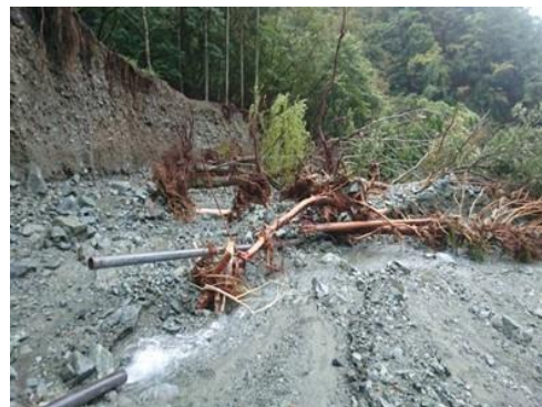
写真 3-18 導水管破損（台風第 19 号；神奈川県山北町 玄倉配水池）
