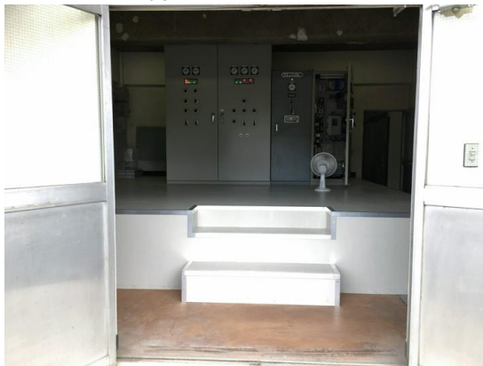
電気設備架台設置
