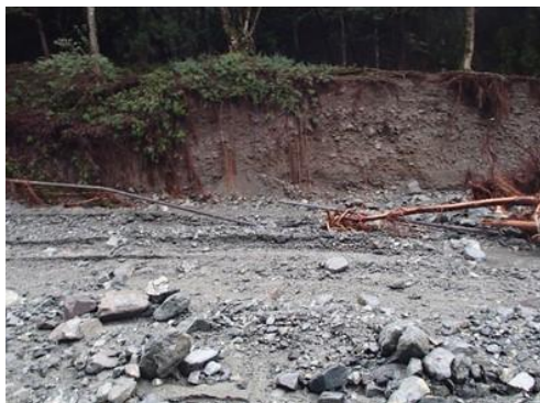
写真 3-18 導水管破損（台風第 19 号；神奈川県山北町 玄倉配水池）
