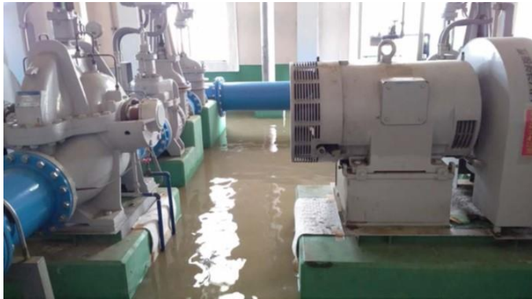
写真 3-2 送水ポンプ室浸水、地下ポンプ井への濁水流入 (台風第 19 号；福島県いわき市 平浄水場)
