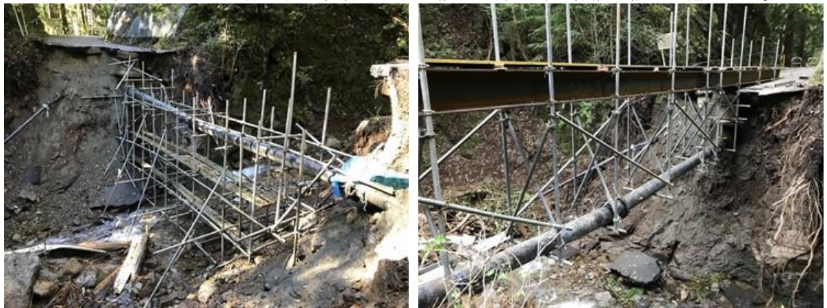
写真 3-48 地盤崩落による継手離脱の補修 （台風第 19 号；神奈川県清川村宮ヶ瀬）
