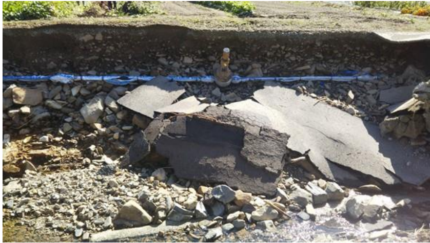
管路状況（大きな傷や継手の抜出しなし）
