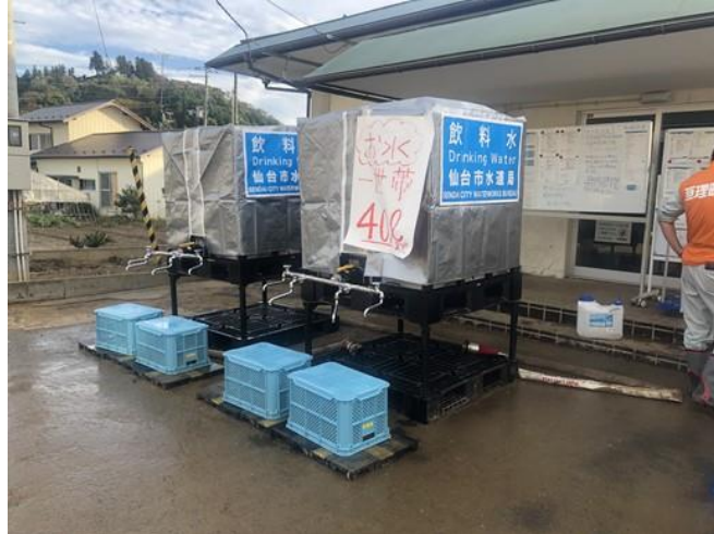
写真 5-8 仮設水槽による給水（台風第 19 号；宮城県丸森町）
