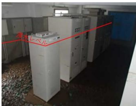
写真 3-6 電気室内浸水レベル（台風第 19 号；福島県いわき市 下平窪取水場）
