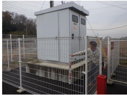
受電設備基礎嵩上げ
