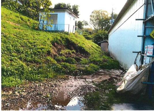
写真 3-28 法面の崩落（台風第 19 号；茨城県大子町 大生瀬三ヶ掛加圧機場）
