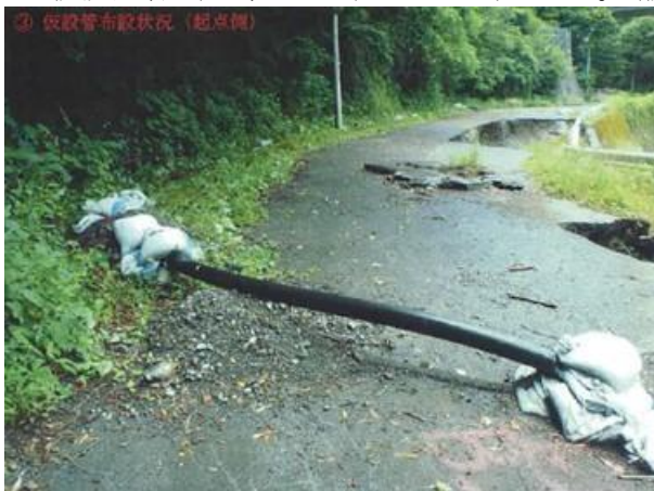
仮設管布設状況①
