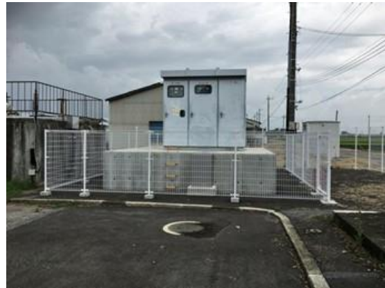
受電設備基礎嵩上げ
