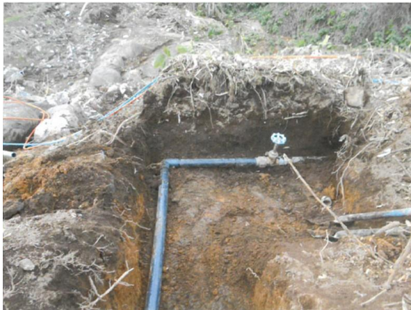
写真 3-40 仮設配管（台風第 19 号；埼玉県神川町大字二ノ宮）
