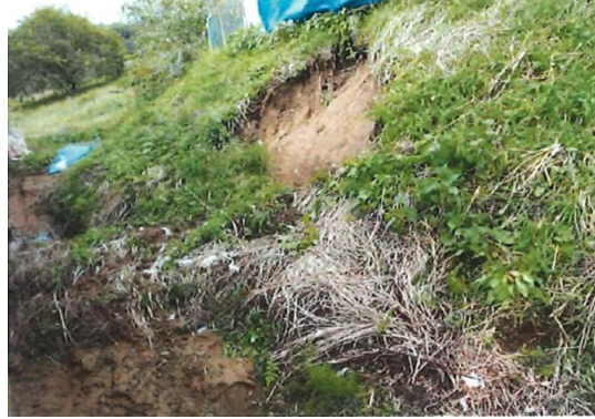
写真 3-28 法面の崩落（台風第 19 号；茨城県大子町 大生瀬三ヶ掛加圧機場）
