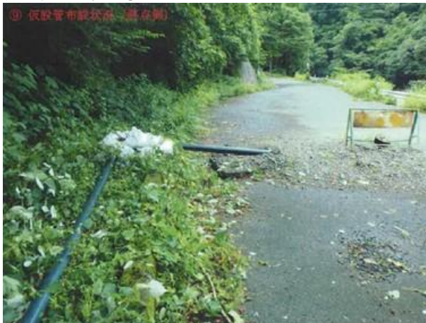
仮設管布設状況③
