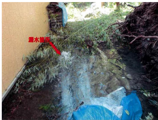
写真 2-3 倒木の根による埋設管の破損（台風第 15 号；千葉県鴨川市）
