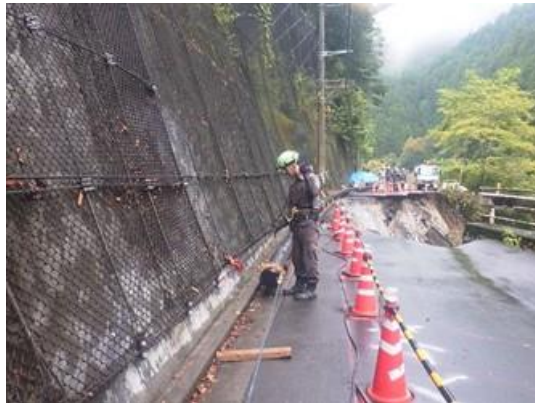
写真 3-50 仮設配管（台風第 19 号；東京都水道局 奥多摩町日原）
