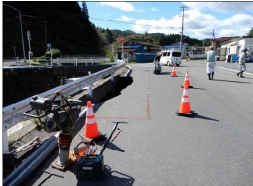
写真 3-33 道路崩落による管路の破断（台風第 19 号；宮城県南三陸町入谷字鏡石 5-3 付近）
