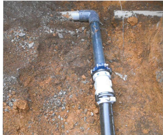
写真 3-40 仮設配管（台風第 19 号；埼玉県神川町大字二ノ宮）
