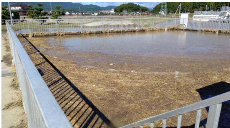
写真 3-4 逆洗排水池濁水・ごみ混入（台風第 19 号；福島県いわき市 平浄水場）
