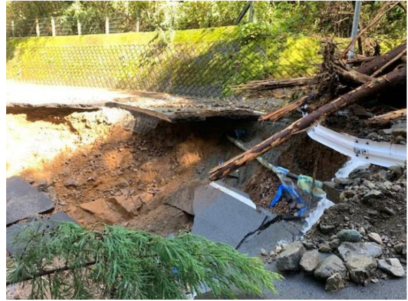
写真 3-43 道路崩落による管体の被害（台風第 19 号；神奈川県相模原市緑区青根）
