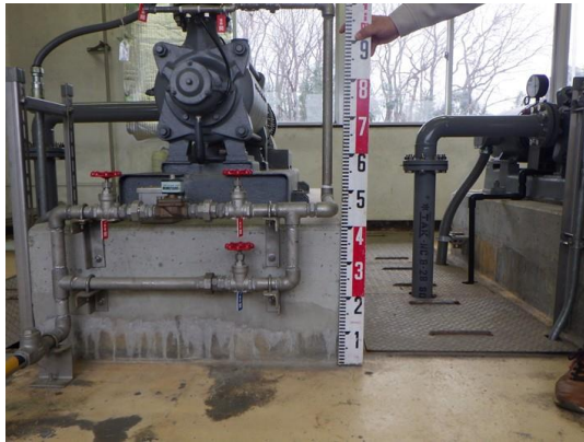
配水ポンプ基礎嵩上げ
