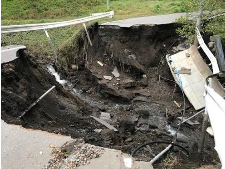
写真 3-38 水流及び土石流による道路構造物と管路の流出の応急復旧 (台風第 19 号；群馬県長野原町大字応桑)
