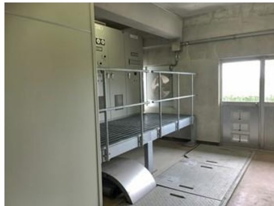
電気設備架台設置
