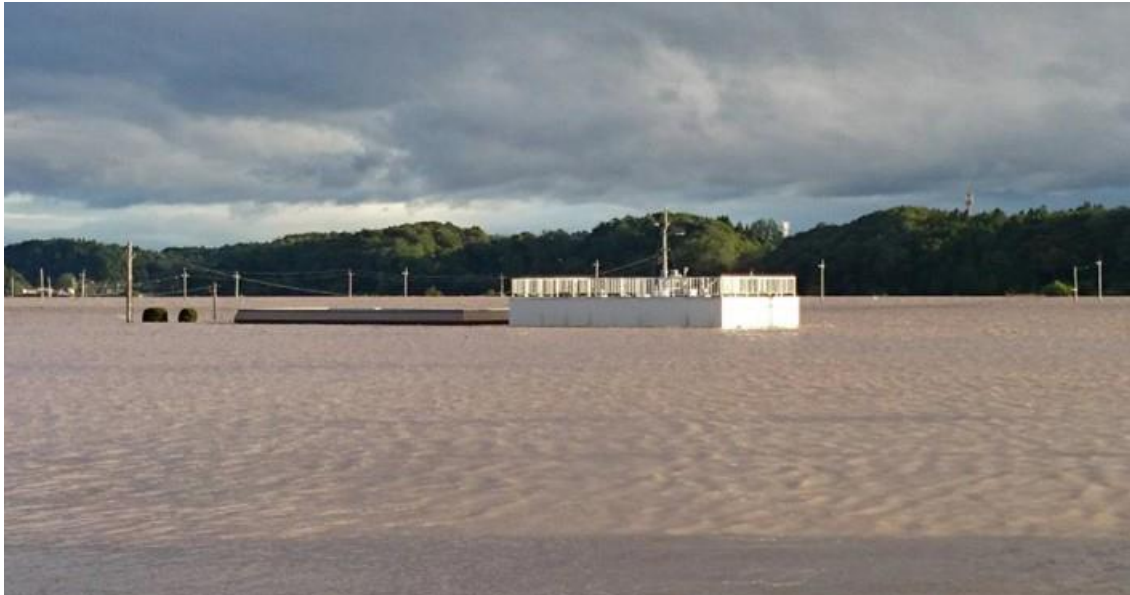
写真 3-9 成田浄水場 機械電気室（左）配水池（右）（台風第 19 号；福島県鏡石町 成田浄水場）
