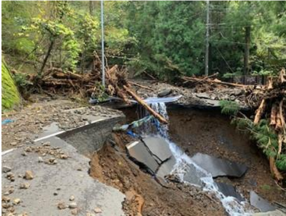
写真 3-43 道路崩落による管体の被害（台風第 19 号；神奈川県相模原市緑区青根）
