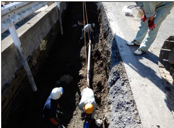
写真 3-34 道路崩落による管路の破断の本復旧 （台風第 19 号；宮城県南三陸町入谷字鏡石 5-3 付近）
