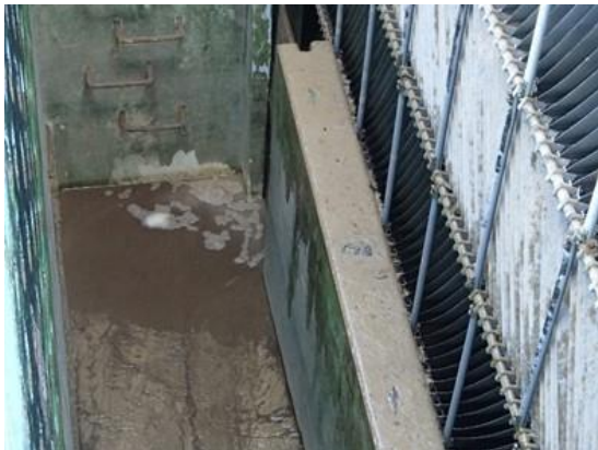
写真 3-27 浄水場への土砂流入（台風第19号；神奈川県山北町 皆瀬川浄水場）
