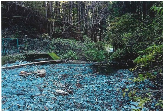
写真 3-23 取水堰への土砂堆積、流入（台風第 19 号；茨城県大子町 上野宮浄水場）
