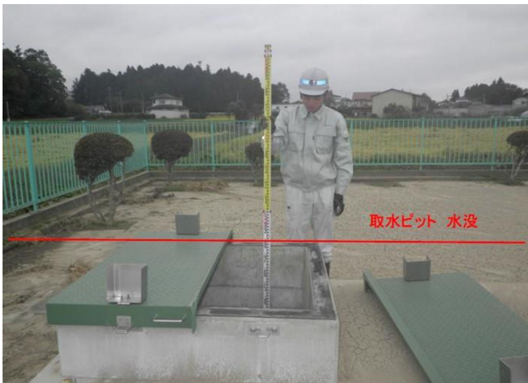
写真 3-10 水没した取水ピット（台風第 19 号；福島県鏡石町 成田浄水場）
