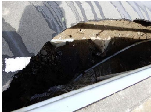
写真 3-33 道路崩落による管路の破断（台風第 19 号；宮城県南三陸町入谷字鏡石 5-3 付近）
