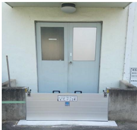
写真 4-6 止水板（埼玉県毛呂山町 苦林浄水場）
