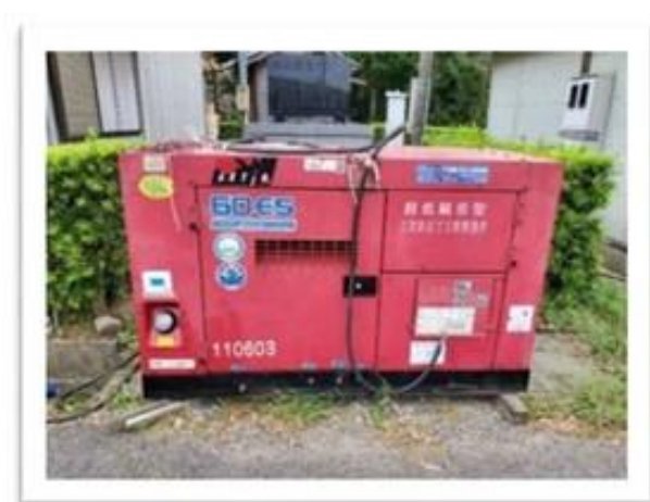
写真 5-6 可搬型発電機設置 （台風第 15 号；千葉県かずさ水道広域連合企業団 大田和加圧ポンプ場）
