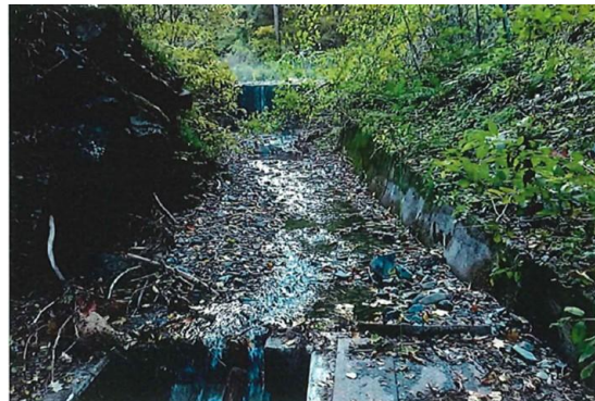
写真 3-23 取水堰への土砂堆積、流入（台風第 19 号；茨城県大子町 上野宮浄水場）
