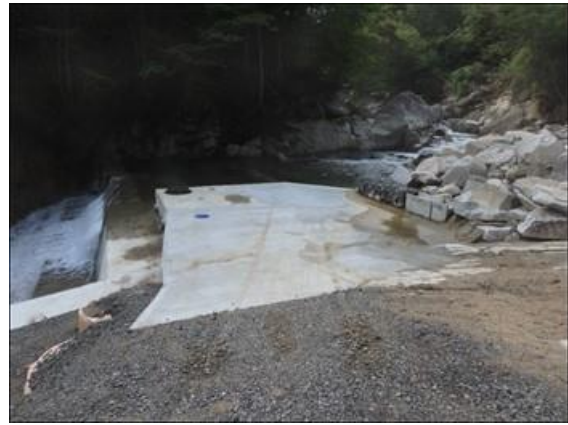
写真 4-22 管理道路工（宮城県丸森町 鷲の平取水口）
