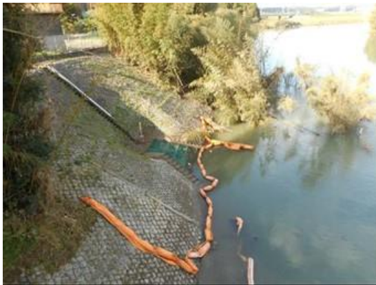
写真 3-16 河川増水による護岸崩落（台風第 19 号；茨城県水戸市 枝内取水場）
