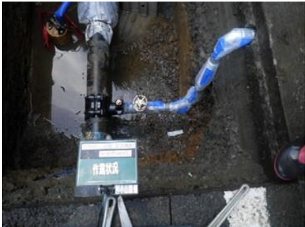
写真 3-43 道路崩落による管体の被害（台風第 19 号；神奈川県相模原市緑区青根）
