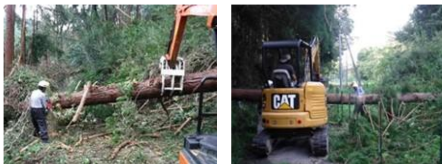
写真 5-7 道路復旧、倒木撤去（台風第 15 号；千葉県かずさ水道広域連合企業団）
