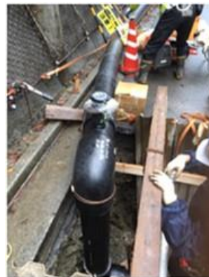
写真 3-50 仮設配管（台風第 19 号；東京都水道局 奥多摩町日原）
