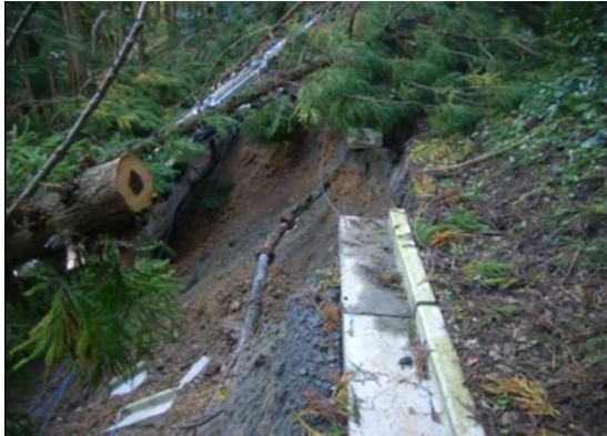
写真 3-45 地盤崩落による継手離脱（台風第 19 号；埼玉県東秩父村大字御堂）
