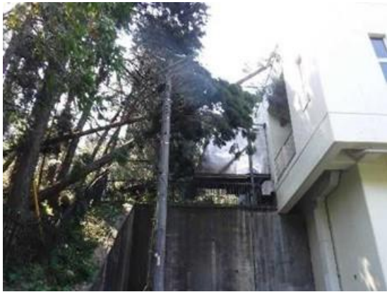
写真 2-1 受電箇所への倒木（台風第 15 号；千葉県かずさ水道広域連合企業団 第 2 中継ポンプ場）
