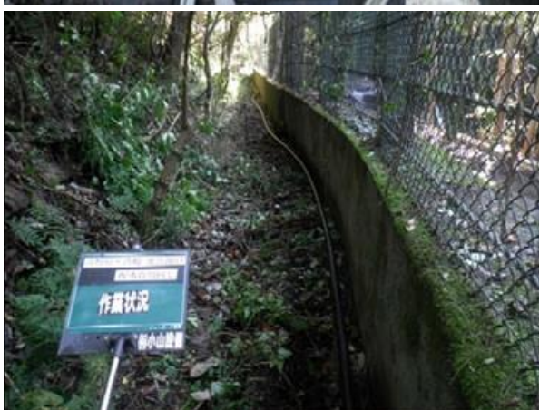
写真 3-44 道路崩落による管体の被害の応急復旧 （台風第 19 号；神奈川県相模原市緑区青根）
