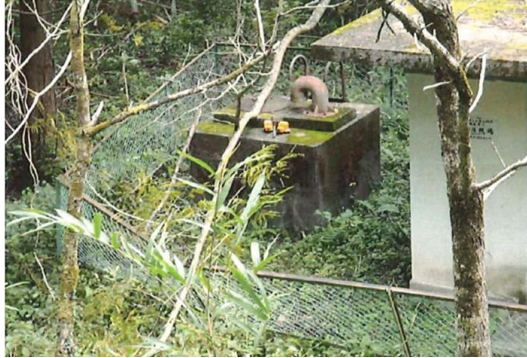
写真 3-31 風倒木によるポンプ井受水槽の蓋の開閉不能 (台風第 19 号；茨城県大子町 西金第 5 加圧機場)
