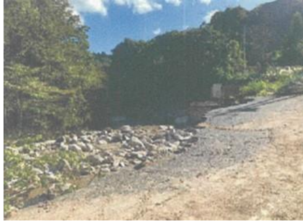
写真 3-21 取水口流出（台風第 19 号；宮城県丸森町 黒佐野取水堰）
