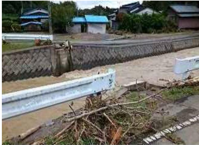
写真 3-58 橋梁の流失による管路の流失（台風第 19 号；宮城県登米市東和町 歩道橋添架管）
