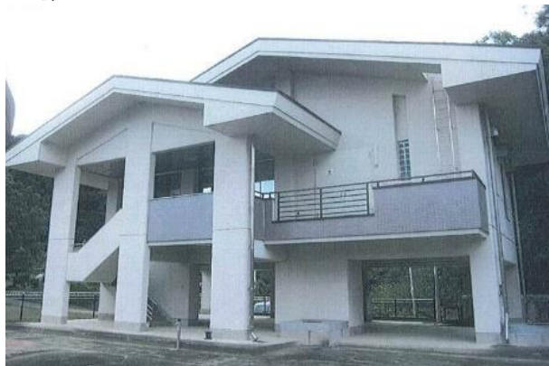
写真 4-12 電気設備を上層階に設置（栃木県茂木町 那珂川取水場）
