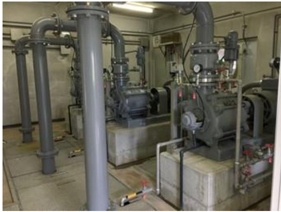
配水ポンプ基礎嵩上げ
