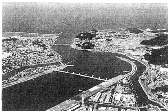
本市の重要な水源である遠賀川河口堰
