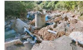
丸森町石羽浄水場の取水口流出
