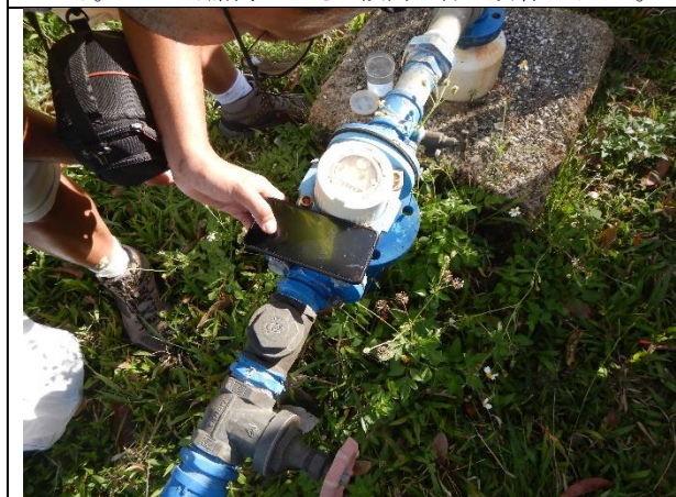
写真-23: ワークショップ内の新規井戸②(ババウ島) TWB のワークショップ敷地内に 2020 年に新設された井戸 (No.120)。揚水量 3.4l/sec、深度 35m、電気伝導度は 1,385 \mu S/cm と WHO の基準値よりやや低い。
