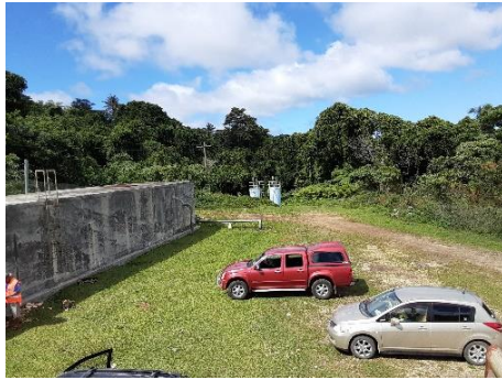
沈殿池と急速ろ過池 浄水池天端から撮影
