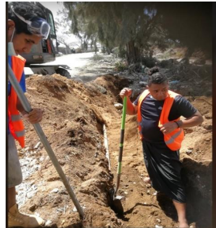
津波により被害を受けた配水本管の修復状況(トンガタブ島)
