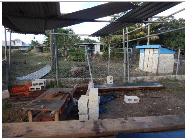
写真-13: 集水埋渠の揚水ポンプ設備③(リフカ島)
