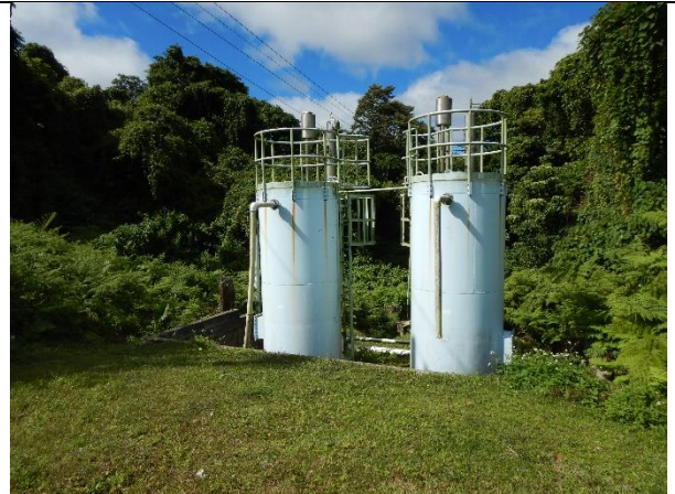
写真-4: マタヴァイ浄水場の故障したろ過機 (エウア島)
