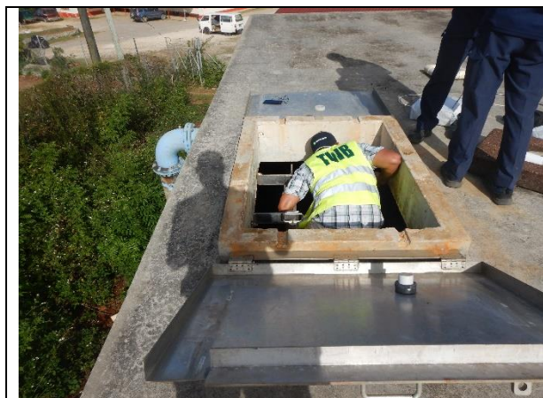
写真-25: 既設配水池 (ババウ島)
