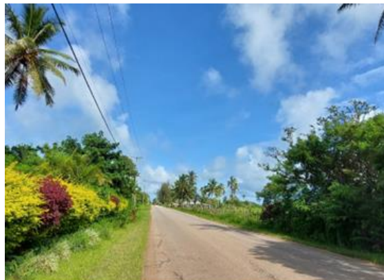
配管布設予定道路(トゥクアホ道路) (2)
