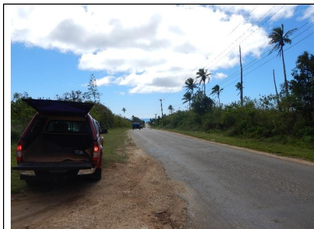
写真-7: アスベスト管の残存箇所(エウア島) 約 1km のアスベスト管が残存しており、更新が必要である。
