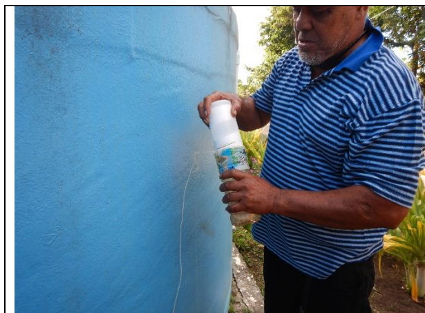
写真-19: 次亜塩素酸タブレットによる塩素消毒(リフカ島) リフカ島では、次亜塩素酸タブレット(ニュージーランドから輸入)をペットボトルに入れ、配水池内に吊り下げることで、マニュアルにより滅菌処理を行っている。
