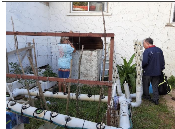
写真-21: 宿泊先の雨水貯水施設(ハアパイ諸島) リフカ島に隣接するフォア島の宿泊先の雨水貯水施設。水道が通っておらず、飲用水を含めた生活用水を雨水に頼っている。ハアパイ諸島ではその傾向が特に顕著であった。
