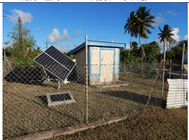
写真-12: 集水埋渠の揚水ポンプ設備②(リフカ島) ヒビフォ地区にある集水埋渠の角に位置する揚水ポンプ (No.115)。ソーラー電力駆動。現場測定時(2022 年 8 月)の電気伝導度は 1,380 \mu\text{S}/\text{cm} で、WHO の基準値以下であった。
