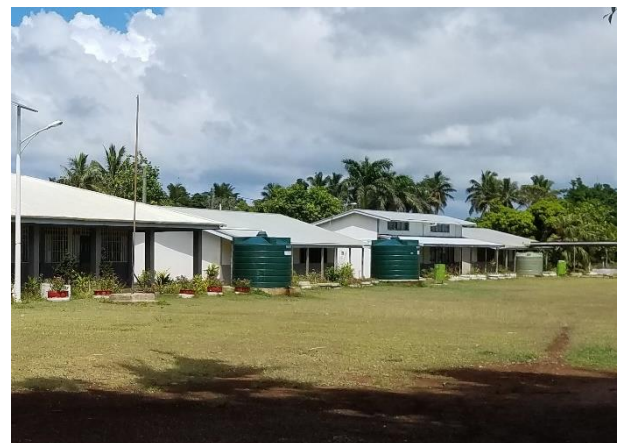
写真 2.1 学校に設置された雨水集水設備
