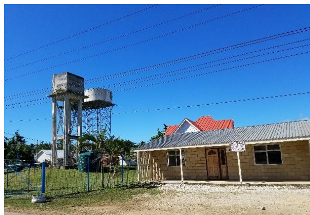
写真 2.7 村落部の水道施設
