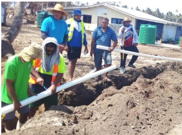
津波により被害を受けた配水本管の修復状況(トンガタブ島)
