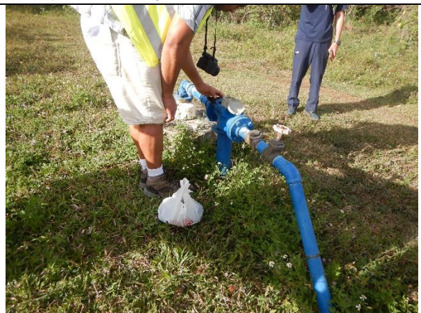
写真-22: ワークショップ内の新規井戸①(ババウ島) TWB のワークショップ敷地内に 2020 年に新設された井戸 (No.119)。揚水量: 3.5l/sec、深度 35m、電気伝導度は 2,167 \mu S/cm と WHO の基準値を超過している。
