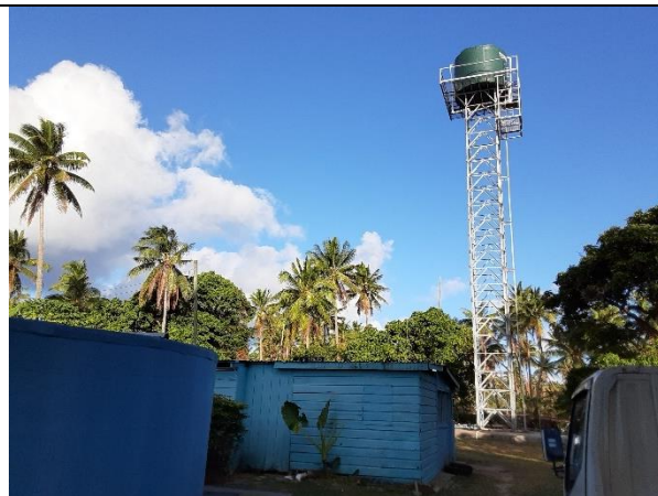
写真-18: TWB ハアパイ支所内の高架水槽 (リフカ島)
