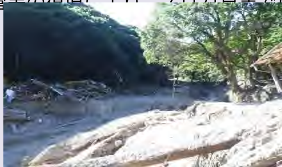
土砂崩れ等で破損した配水施設 (静岡県熱海市)
