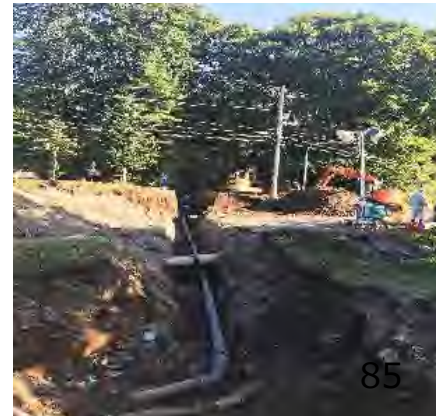
導水管補修状況 (北海道厚真町)
