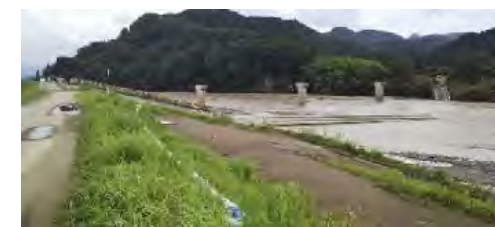
送水管を添架していた道路橋の流出 (熊本県球磨村)
