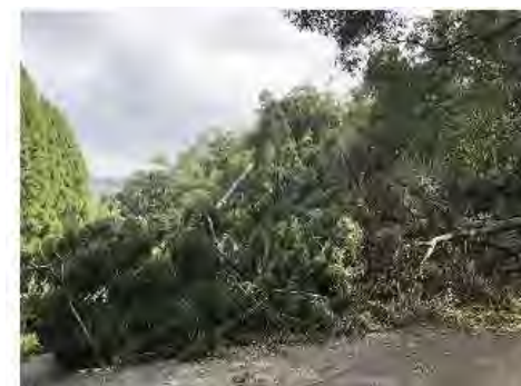
配水場門扉付近の被災
