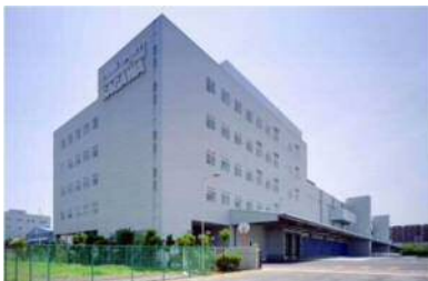
新砂配送センター
