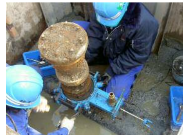
補修弁取替工法
