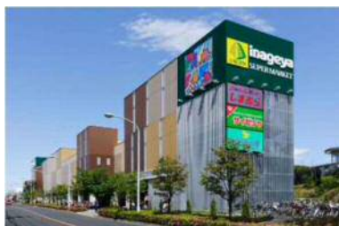
武蔵境共同ビル
