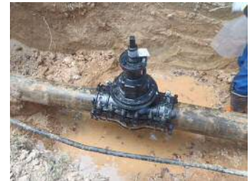
緊急不断水工事
