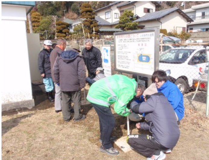
写真 仮設給水栓の組立
