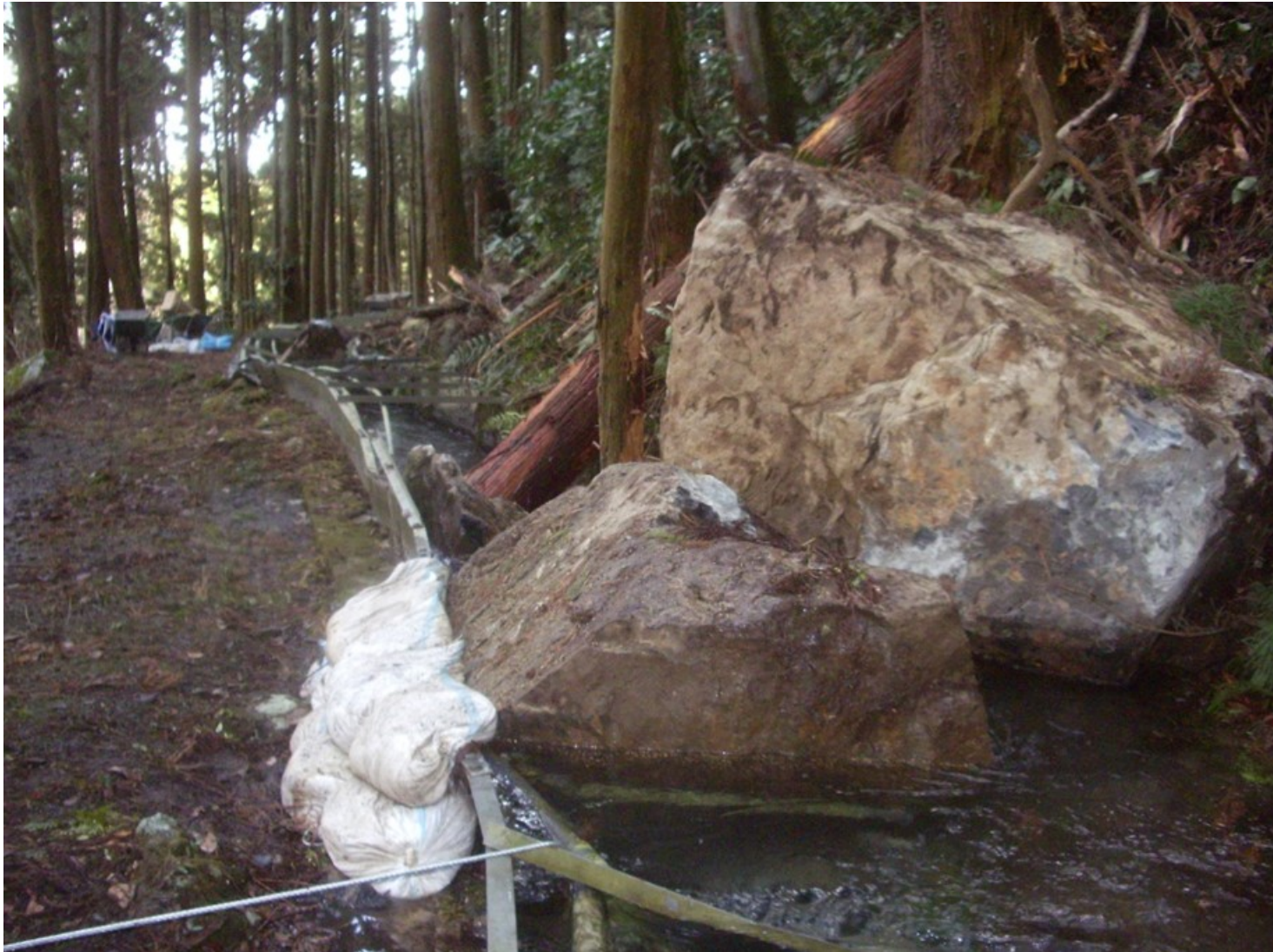
写真 上野原浄水場導水路の落石状況
