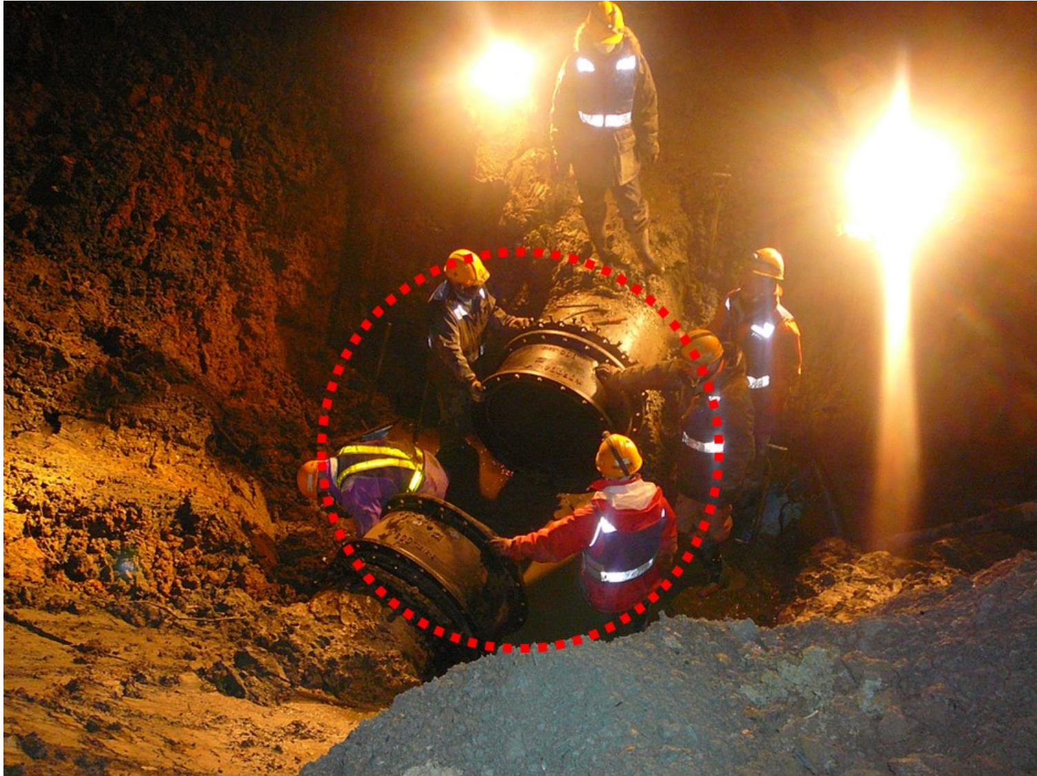
写真 山玉浄水場送水管(φ800mm)修繕状況
