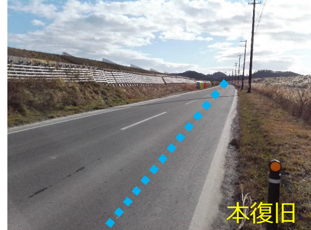
④道路（配水管）の復旧完了
