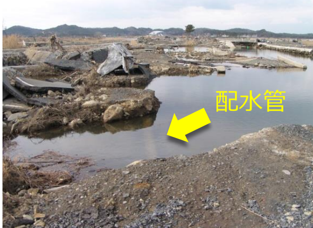
①津波による道路（配水管）流出
