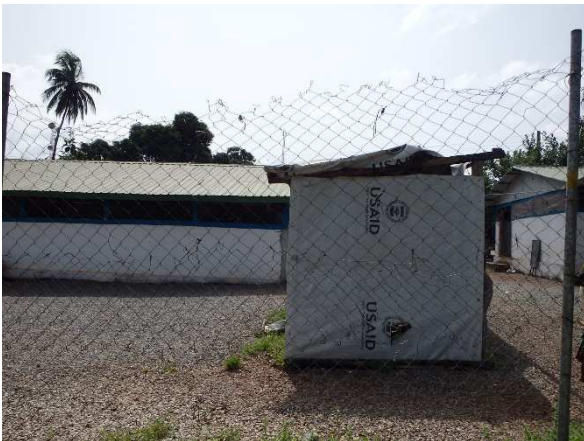
写真-17 デブレカ県立病院内に設置された USAID 支援によるエボラ疑い患者隔離施設
