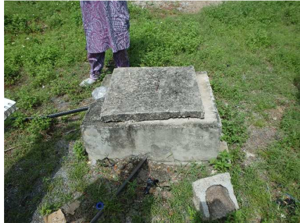
写真-16 同左 病院敷地内にある井戸で 3 年前に設置したが、塩水が混入している。
