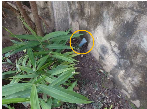
写真-24 世帯用水道接続管（デブレカ市ケイタヤ地区）
