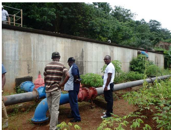
写真-14 400 m 3 の配水池
