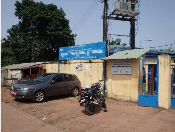
写真-15 デブレカ市にあるデブレカ県立病院（配水区域内） SEG からの水道水の供給は、1 回/週であり、水圧も弱い。
