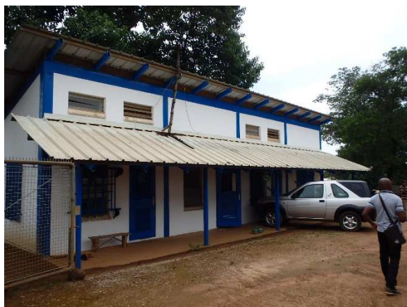
写真-10 浄水処理（中和＋塩素消毒） ディーゼル発電機、受電設備（昇圧トランス含む）
