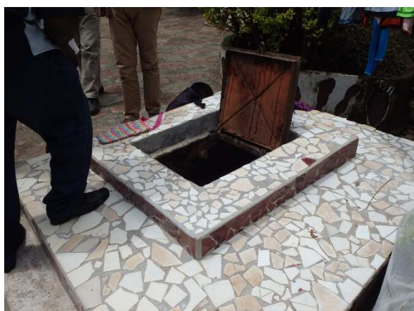
写真-27 コヤ市ナキリ地区(配水区域内)の民家敷地内にある個人浅井戸。近くに配水管はあるが水は来ていない。
