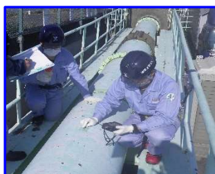
水管橋の点検
