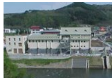
N市浄水場
