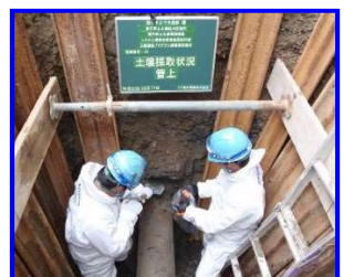
埋設環境調査
