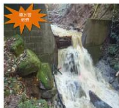
10月12日記録的な豪雨により土砂崩れが発生 取水口からの送水管が破損し断水
