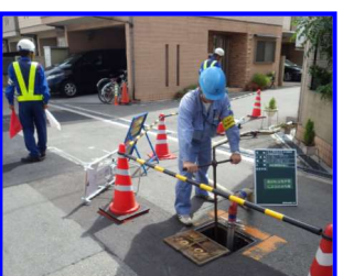
断・通水作業
