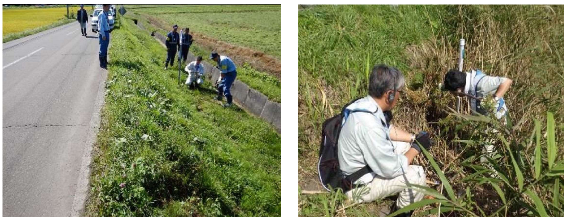
写真 6-2 既設管路・仕切弁等の位置の探索状況（安平町）
