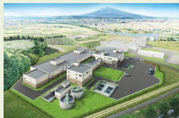
樋の口浄水場等建設事業 〔 浄水場(3.8 万 m 3 /日)建設等及び 市内 87 箇所施設の運転管理 〕
