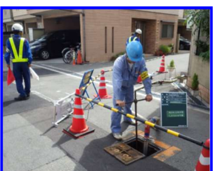
断・通水作業
