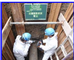
埋設環境調査
