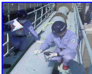
水管橋の点検
