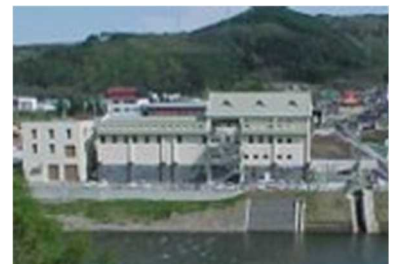
N市浄水場
