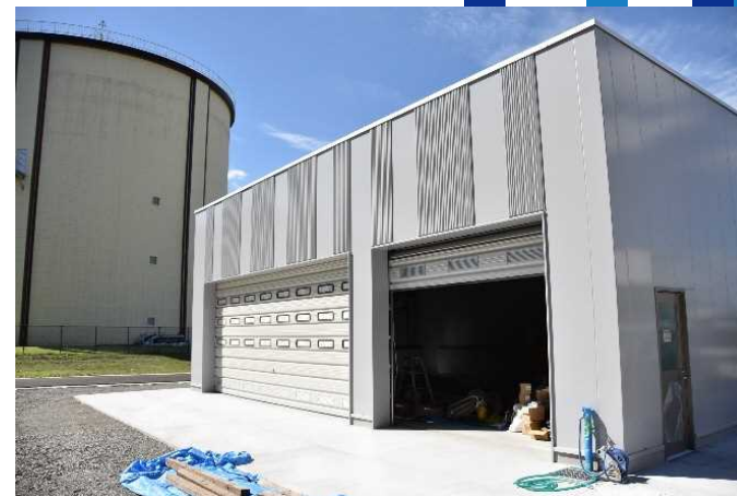
給水車車庫と藤沢配水池
