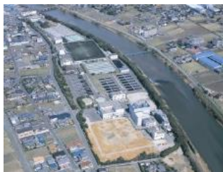
中部浄化センター
