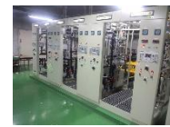
設備(資産の3割) 維持管理・更新工事
