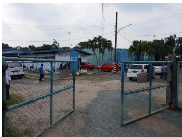
アンヘレス市水道区施設入口②
