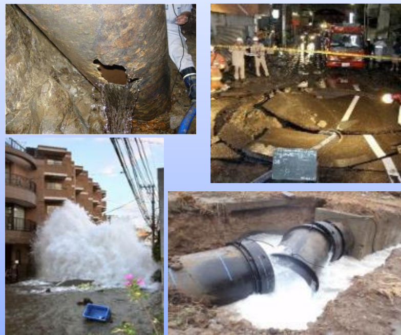
老朽化による事故の例
