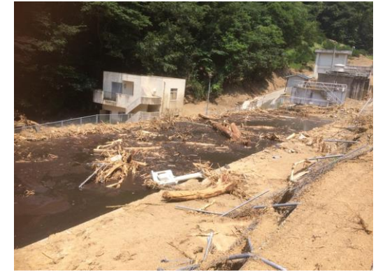
被害を受けた吉田浄水場
