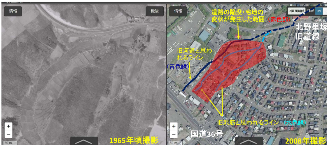
写真 2-5 道路・宅地の変状が著しい範囲の状況 (写真方向⑤)
