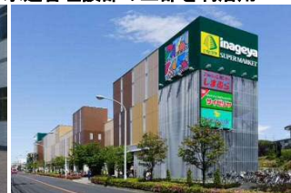
武蔵境共同ビル
