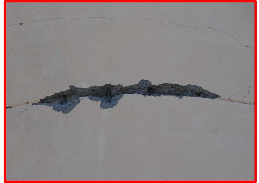
写真 地震動によりクラックが発生した八幡小路高架タンク
