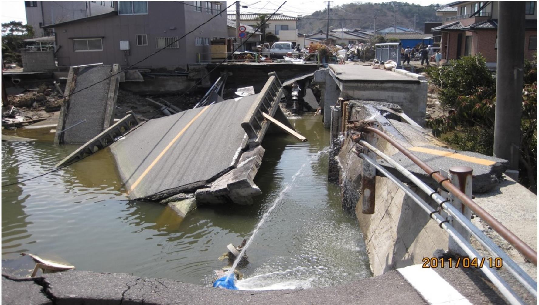
写真 津波により橋梁ごと流出したφ150mm配水管(永崎:大平橋)
