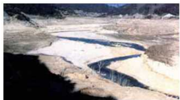
矢作ダム貯水池 (平成6年9月) (出典：矢作川水系河川整備基本方針 国土交通省)
