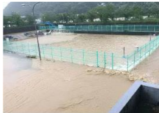
本郷取水場 沈砂池(水没) H30.7.7 午前7時
