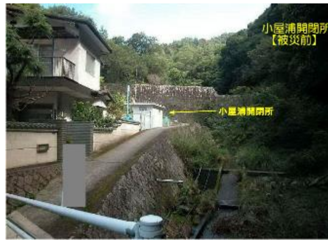
小屋浦開閉所 (被災前)
