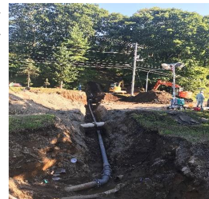
厚真町 新町浄水場導水管補修
