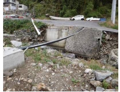
応急復旧後状況 仮設送水管河川横断 (平成 23 年 10 月 26 日)
