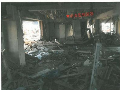
市役所庁舎内部 水道事業所
