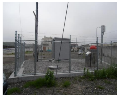
復旧後 (平成24年6月21日)
