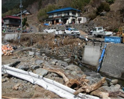
被災状況 津波により落橋 (平成 23 年 4 月 1 日)
