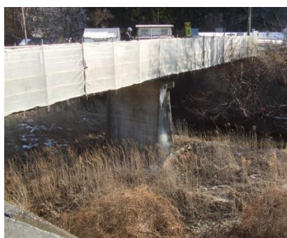
被災前 上部工補修工事中
