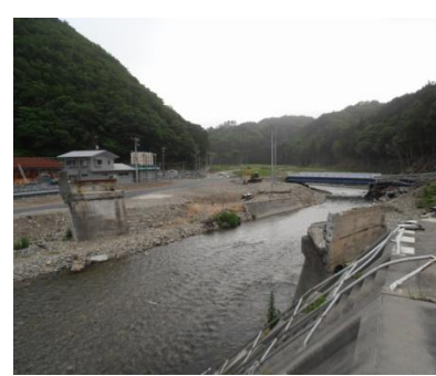
上流側仮設橋、配水管添架 (平成 24 年 6 月 21 日)
