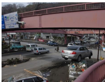
被災状況 (平成23年3月14日)
