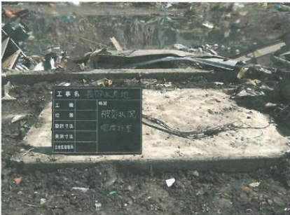
濁度計設備跡
