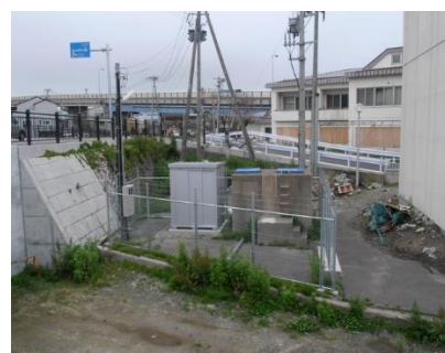
復旧後 (平成24年6月21日)
