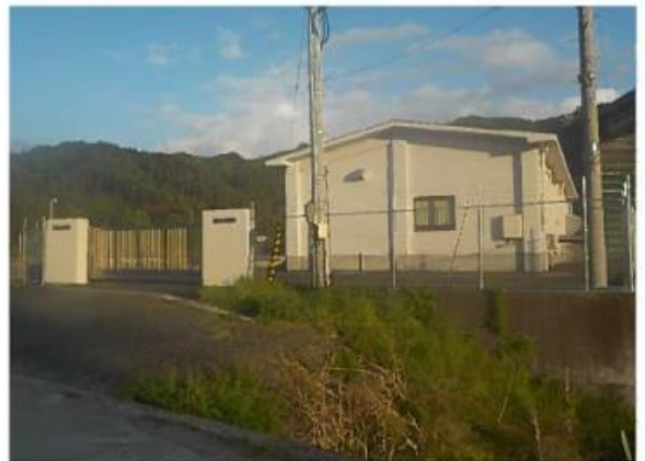
復興・復旧後の写真 (外観)
