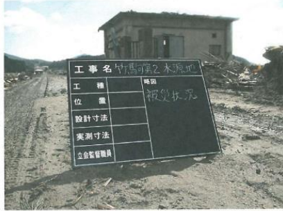
電気・薬品室
