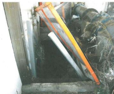
取水井戸ポンプ室下 井戸内部
