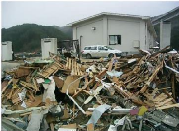
被災直後の写真 (外観)
