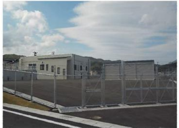
復興・復旧後の写真 (外観)
