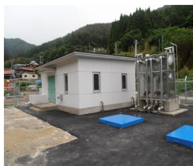
復旧後状況 (平成 24 年 6 月 21 日)
