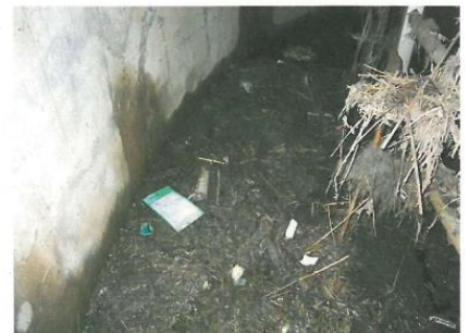
取水井戸ポンプ室下 井戸内部
