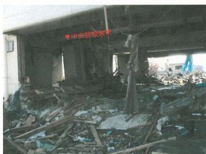
市役所庁舎内部 水道事業所
