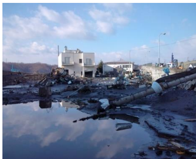
被災状況 (平成23年3月12日)
