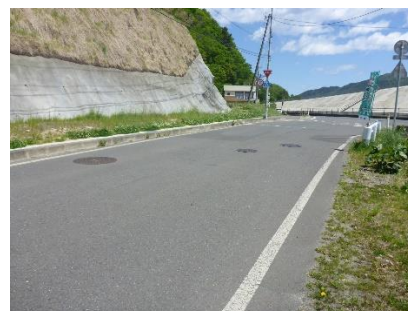
復旧後 (配水管は平成 23 年度復旧) (令和 3 年 5 月 10 日撮影)
