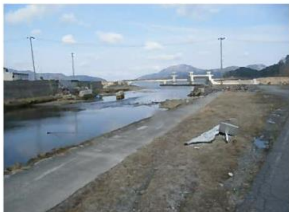
被災直後の写真 (外観)
