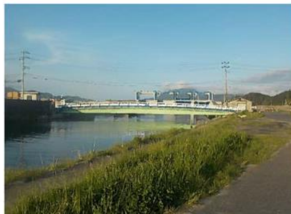
復興・復旧後の写真 (外観)
