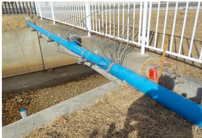
明内川中流の橋梁添架管の復旧
