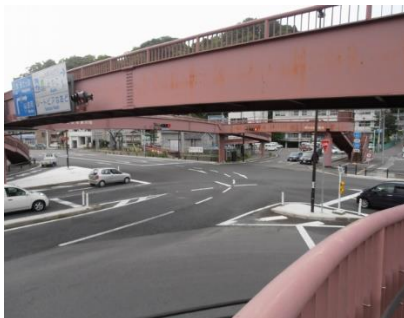
復旧後 (平成24年6月21日)
