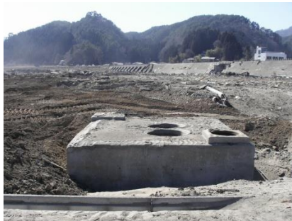
被災状況 (平成 23 年 4 月 6 日)
