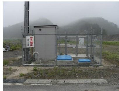
復旧後 (平成 24 年 6 月 21 日)
