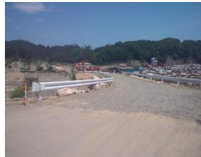
応急復旧後状況 仮設道路内、送水管埋設 (平成 23 年 7 月 31 日)
