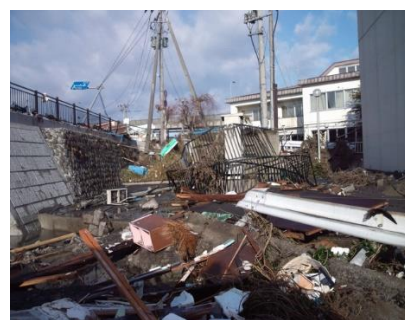
被災状況 (平成23年3月12日)
