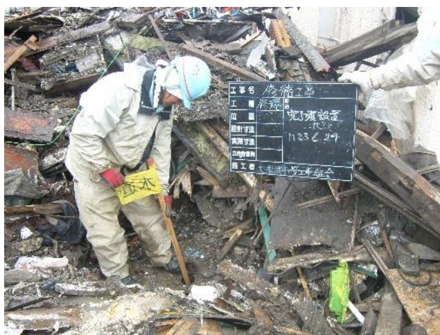
ガレキの中の止水栓の探索・閉栓し、完了旗を設置している状況
