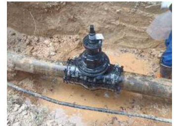
緊急不断水工事
