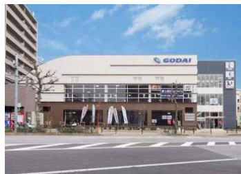
亀戸インドプラザ
