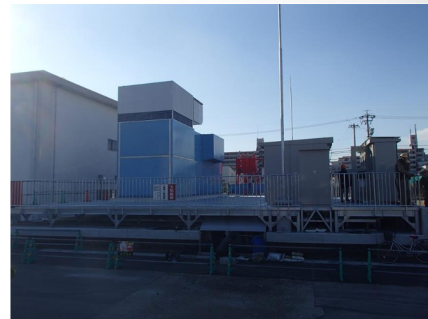
【大治浄水場非常用発電設備の更新】
