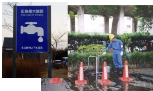
【応急給水施設】
