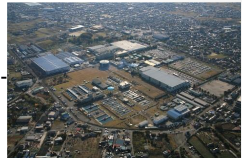
【春日井浄水場】
