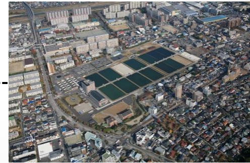
【鍋屋上野浄水場】
