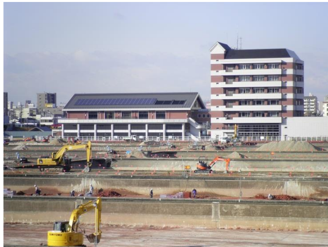
【鍋屋上野浄水場 緩速ろ過池の更新】
