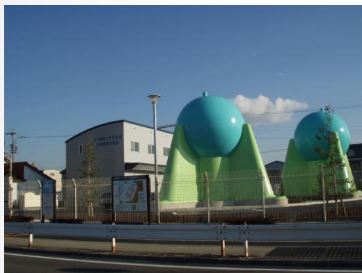
【比良西応急給水センター】
