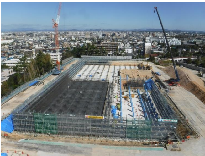
【東山配水場 3号配水池の更新】
