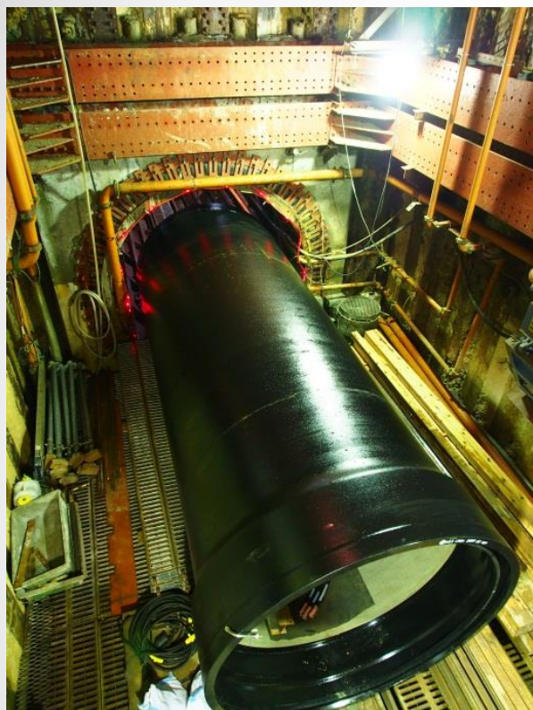
【犬山系導水路A管の更新】
