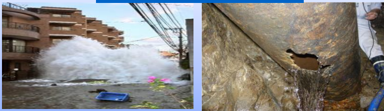
老朽化による事故の例
