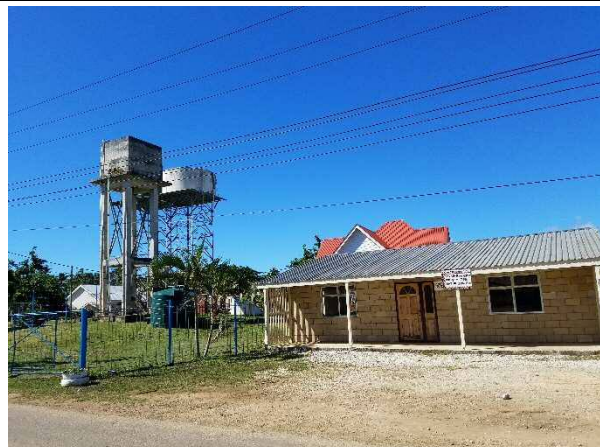
写真-12:村落部の水道施設
