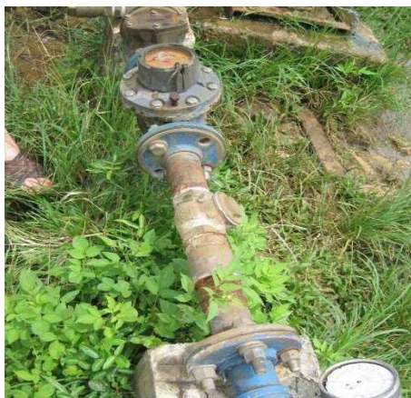
写真 2.1 故障して正常に機能していない流量計
