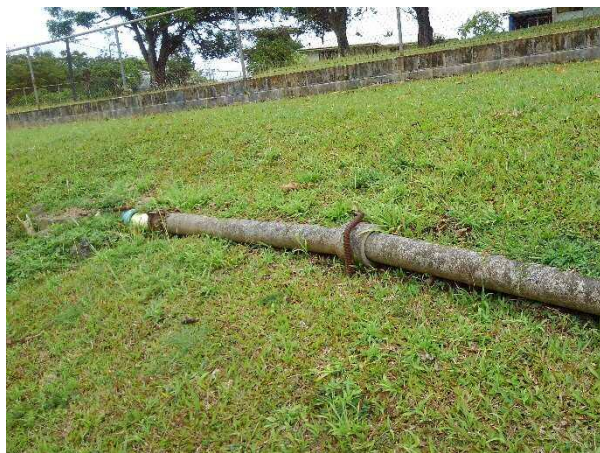
写真-7:アスベスト管(地上露出部)
