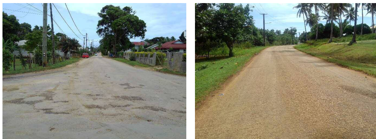
写真 3.2 ババウ島の道路状況（左：Co 舗装、右：珊瑚石灰岩骨材の Co 舗装）
