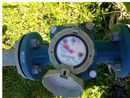
写真 2.1 故障して正常に機能していない流量計
