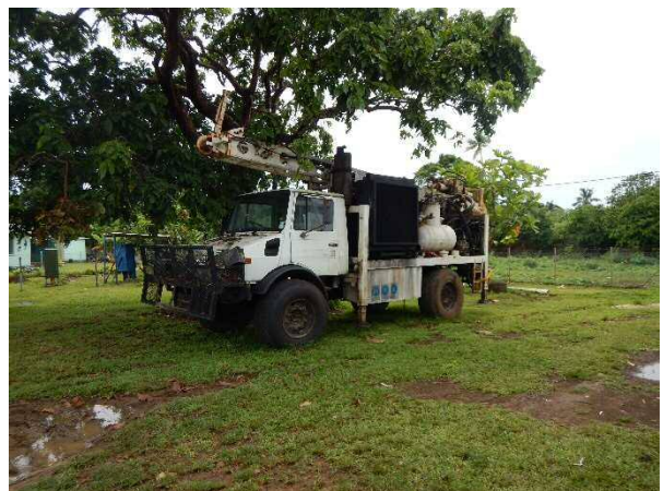
写真-16: 井戸用の掘削機
