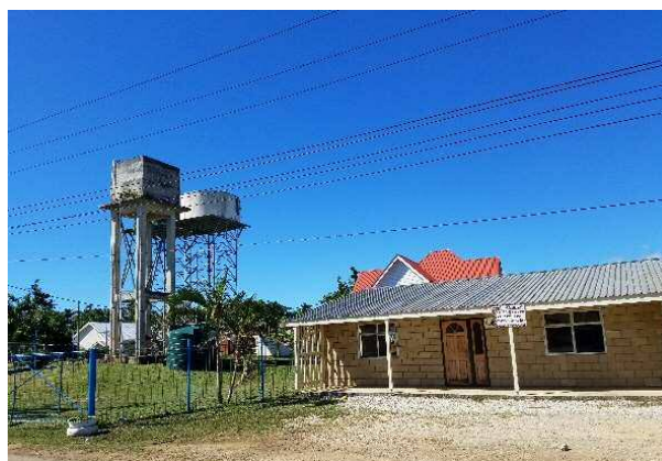
写真 2.4 村落部の水道施設
