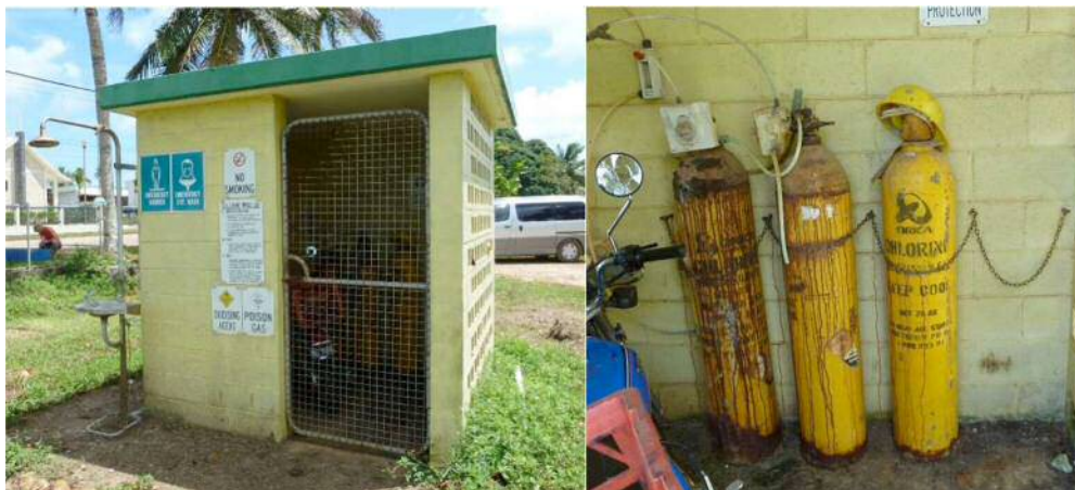
写真 2.2 使用されていない塩素ガス設備
