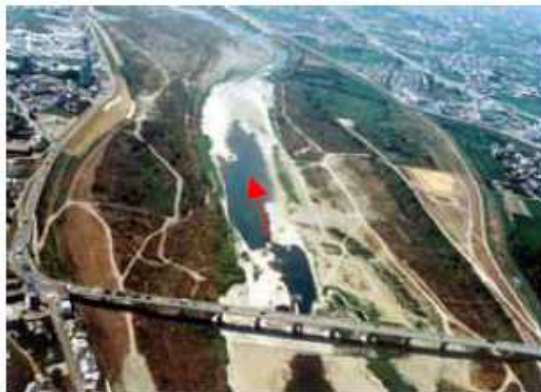
紀の川の瀬切れの状況（H6.8 船戸地点下流）
