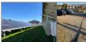
▲写真：目印のない検針箇所
