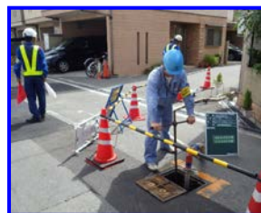
断・通水作業
