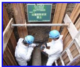
埋設環境調査
