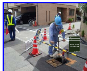
断・通水作業
