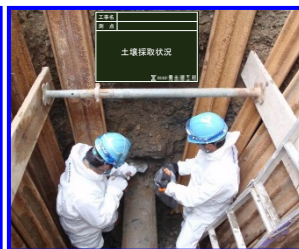
埋設環境調査
