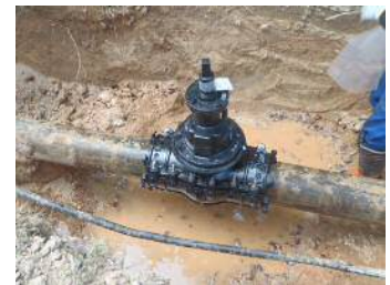
緊急不断水工事
