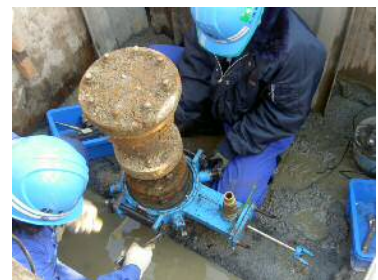
補修弁取替工法
