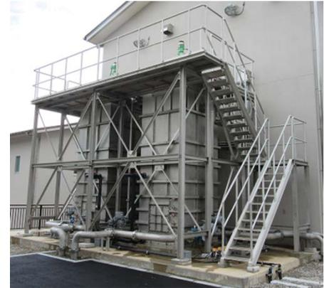
帯磁性イオン交換樹脂(MIEX<sup>®</sup>)処理システム
