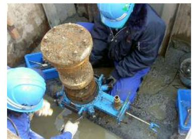
補修弁取替工法
